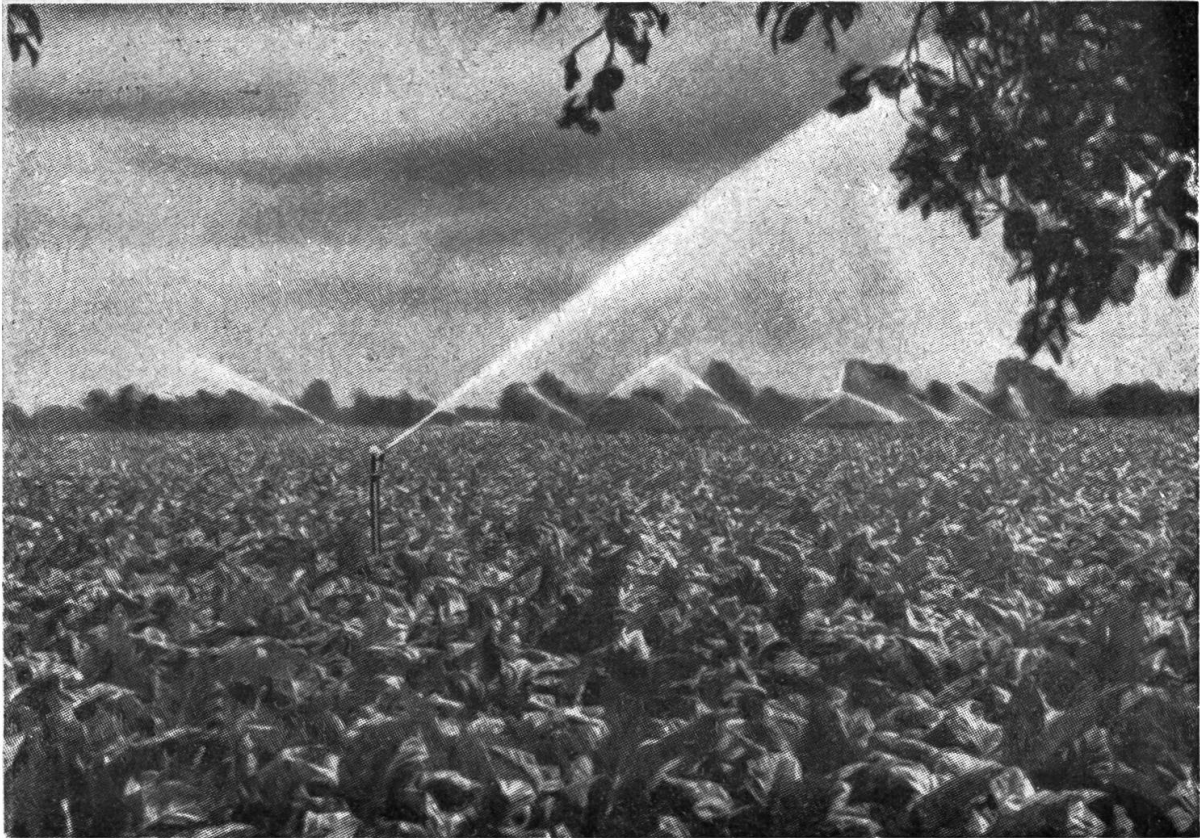
Langsamberegnungs-Anlage mit Perrot-Regner LKA-30 für Tabak-Kulturen
