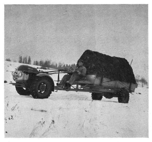
Abb. 8: Einachstraktor KT 10 mit Triebachsanhänger Bucher
