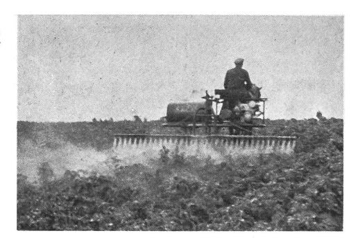
Abb. 12: Nebelblaser mit Querbalken mit 50 Düsen (Arbeitsbreite 8 m)
