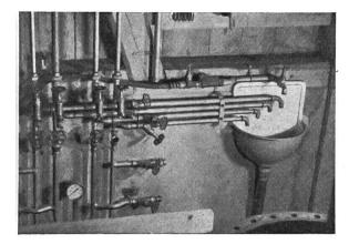
Abb. 3: Verteilerleitungen zu einer stationären Spritzanlage.
