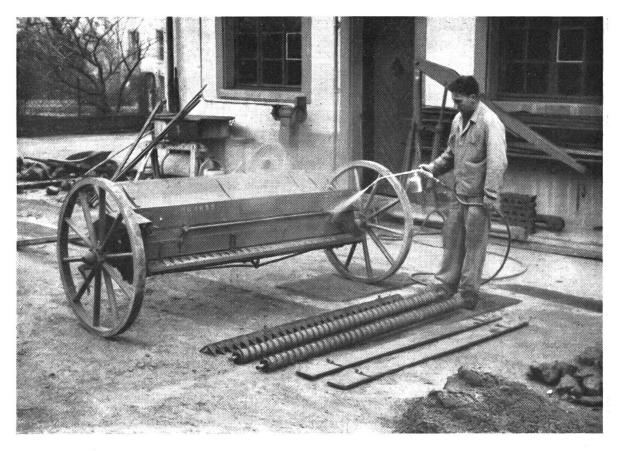
Abb. 11b: Reinigen der Maschine mit Magnusol-Dieselöl-Mischung
