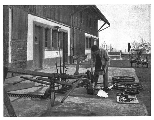
Abb. 11a: Gründliche Revision und Reinigung einer Mähmaschine
