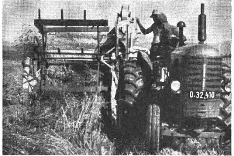
Abb. 6 Mähdrescher im Lagergetreide. Hersteller: Eppler-Buxbaum-Werke A.-G., Wels (Ober-Oesterreich).
