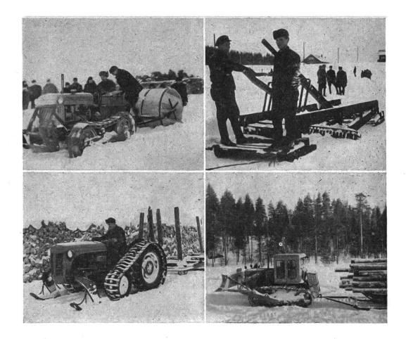
Links oben: Schneewalze mit vorgespanntem leichtem Raupentraktor dient zur Vorpressung
