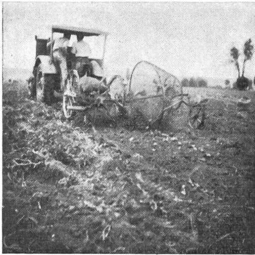
Abb. 1 Seitlich an den Schleuderradgraber montierbarer Fangkorb der Firma Aebi & Co., Burgdorf.
