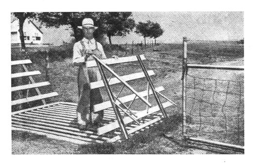
Diese Konstruktion erlaubt Ihnen, mit Wagen und Maschinen ungehindert durchzufahren. Das Vieh dagegen wagt nicht, den Rost zu betreten. Eine einfache, aber sinnvolle Einrichtung!
