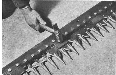
Ausführung Aebi, Burgdorf. Bei zuviel Spiel, Hammerschlag auf Vorderteil des Drückers, ohne unterlegte Klinge. Beim Klemmen, Hammerschlag auf den Hinterteil des Drückers mit unterlegter Klinge (Abb. 21 und 22).
