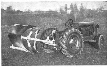
Motrac mit automatischem, durch Motor betriebenen Einmannpflug. - Tiefeneinstellung vom Führersitz aus.
