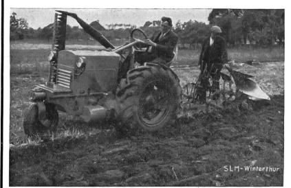
Vorderrodsteuerung und unabhängige Differentiallenkung der Triebräder
