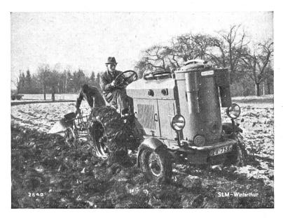
Holzgasgenerator eigener bewährter Bauart Kapazität ca. 40 kg Holz
