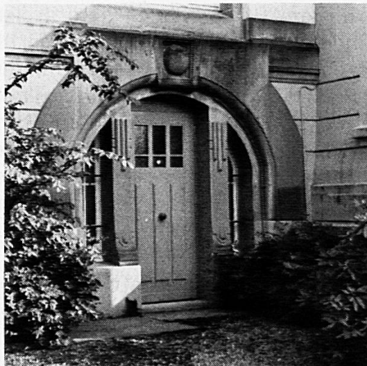
Eine Kellertüre, so schön gearbeitet wie ein Salonfensterflügel
