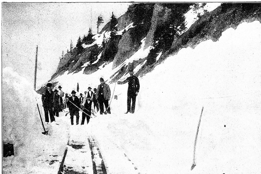
Räumung eines Bergbahngleises.
