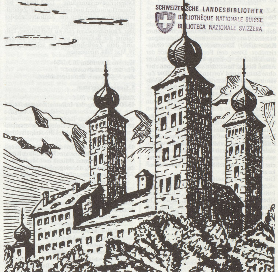
Stockalperschloss in Brig/Château de Stockalper à Brigue
