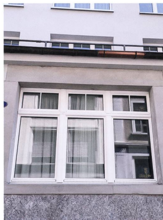
Die neuen Fenster mit Holzrahmen, profiliertem Kämpfer und bei diesen dreiteiligen Fenstern hier auch mit profilierten Pfosten.
