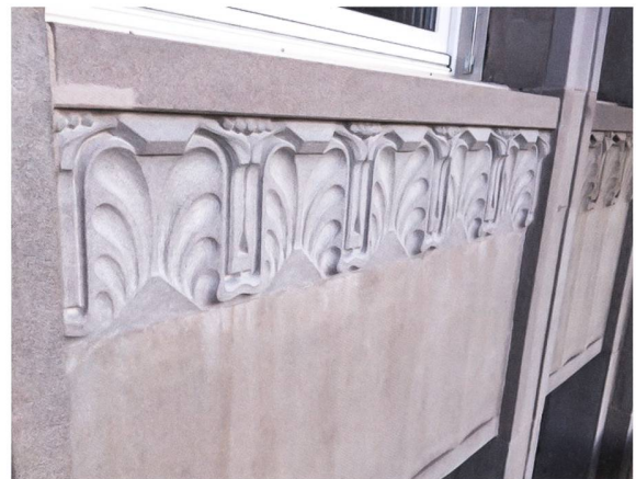
Die Witterung hat der Sandsteinverkleidung über die Jahre zugesetzt. Insbesondere die Dekorelemente wie hier der Palmettenfries im Brüstungsfeld mussten teilweise ersetzt werden, aber auch zahlreiche Fugen wurden erneuert.
