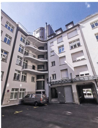
Wie die geschwungenen Balkone offenbaren, konnte die neue Bauweise mit Eisenbeton im Innenhof ihre volle Gestaltungsfreiheit entfalten.
