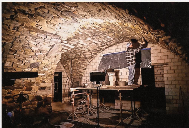
Das Jahr 2020 war geprägt von den Abbruch- und Bauarbeiten am Nordflügel der Prestegg in Altstätten: Ein Arbeiter beim Ausfugen des Kellergewölbes.
