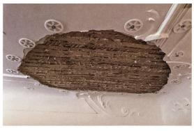
Schadstelle in der Stuckdecke. Da die Ursachen vielschichtig sein können (Erschütterungen, Ermüdungen, Wasserschaden etc.) ist der Schaden selten vorauszusehen. Leider ist durch den Deckenausbruch das Medaillon vollständig zerstört worden und konnte nicht mehr rekonstruiert werden. Auf dem Bild sichtbar ist auch eine Notbefestigung, um weitere Ausbrüche zu vermeiden.
