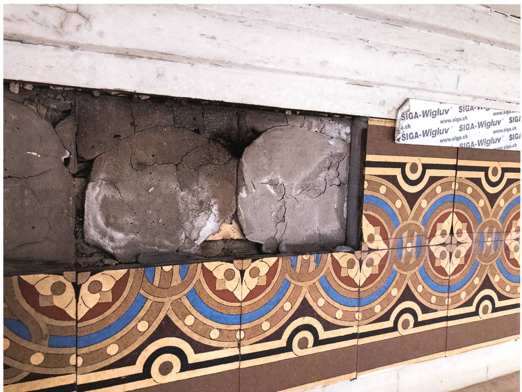
Zwischen Dachuntersicht und Sichtbacksteinmauerwerk befindet sich ein zweireihiger Fries aus Ornamentkacheln. Die Platten wurden in der Vergangenheit mit verschiedensten, zweifelhaften Methoden gesichert – Klebeband, Silikon und dergleichen. Diese Sicherungsmassnahmen wurden wieder entfernt, die losen Platten sorgfältig gelöst und neu fixiert und schliesslich mit einer Klammer gesichert.
