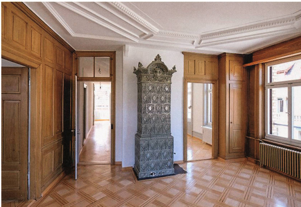
Die innere Ausstattung ist vor allem in den Eckzimmern reichhaltig, mit mehrfarbigem Tafelparkett, raumhohem, hier maseriertem Wandtäfer, üppig profilierter Stuckdecke und jeweils unterschiedlichem Turmofen. Diese Ausstattung ist, mit Ausnahme des später umgebauten Dachgeschosses, in allen Wohngeschossen erhalten, sie bietet noch heute eine hohe Wohnqualität und zeugt von der Handwerkskunst der Jahrhundertwende.
