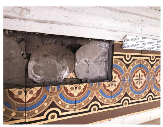
Zwischen Dachuntersicht und Sichtbacksteinmauerwerk befindet sich ein zweireihiger Fries aus Ornamentkacheln. Die Platten wurden in der Vergangenheit mit verschiedensten, zweifelhaften Methoden gesichert – Klebeband, Silikon und dergleichen. Diese Sicherungsmassnahmen wurden wieder entfernt, die losen Platten sorgfältig gelöst und neu fixiert und schliesslich mit einer Klammer gesichert.
