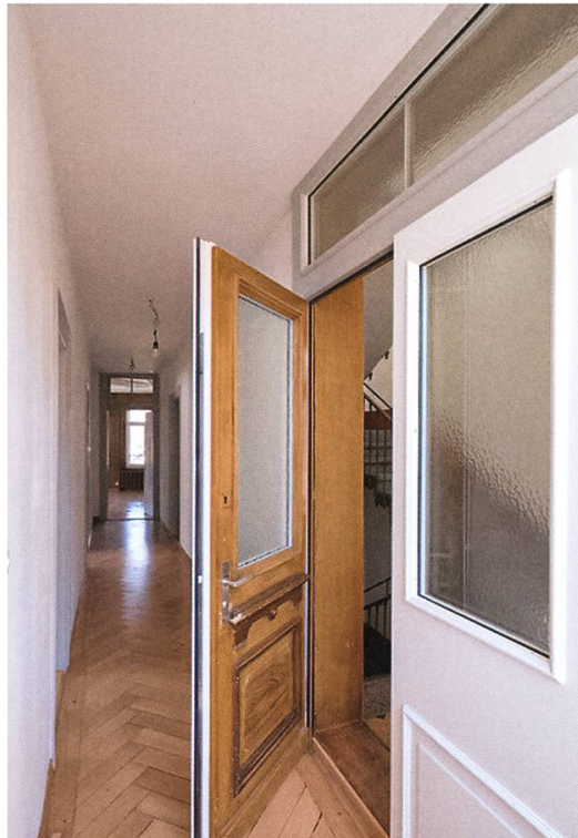
Die aus Brandschutzgründen aufgedoppelten Türen sind zwar etwas dicker, aber gegen das Treppenhaus original erhalten und gegen die Wohnung in der alten Form ergänzt. So bleiben Substanz und gestalterische Qualität erhalten.
