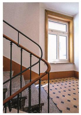
Beim Treppengeländer fehlten einzelne Staketen – ein Glücksfall, dass von genau diesem Modell ein paar Exemplare im Bauteillager der Denkmalpflege vorhanden waren. Sie fanden hier ein neues Zuhause.
