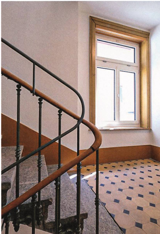
Beim Treppengeländer fehlten einzelne Staketen – ein Glücksfall, dass von genau diesem Modell ein paar Exemplare im Bauteillager der Denkmalpflege vorhanden waren. Sie fanden hier ein neues Zuhause.
