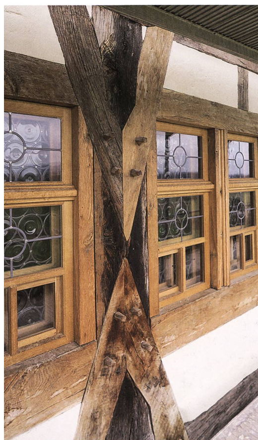
Links: Ersatz von fünfhundertjährigen Holzverbindungen nach traditioneller Handwerksart und Nachbau historischer Fenster am Schloss Zuckenriet, Niederhelfenschwil.
