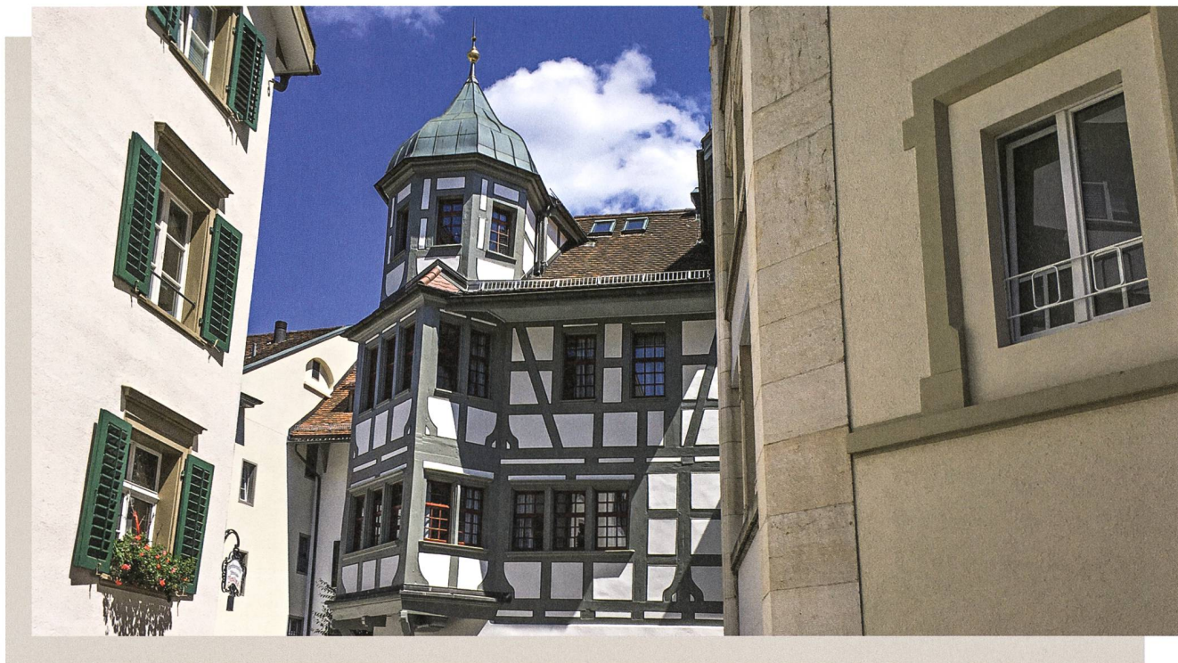
Foto: Denkmalpflege Stadt St. Gallen
