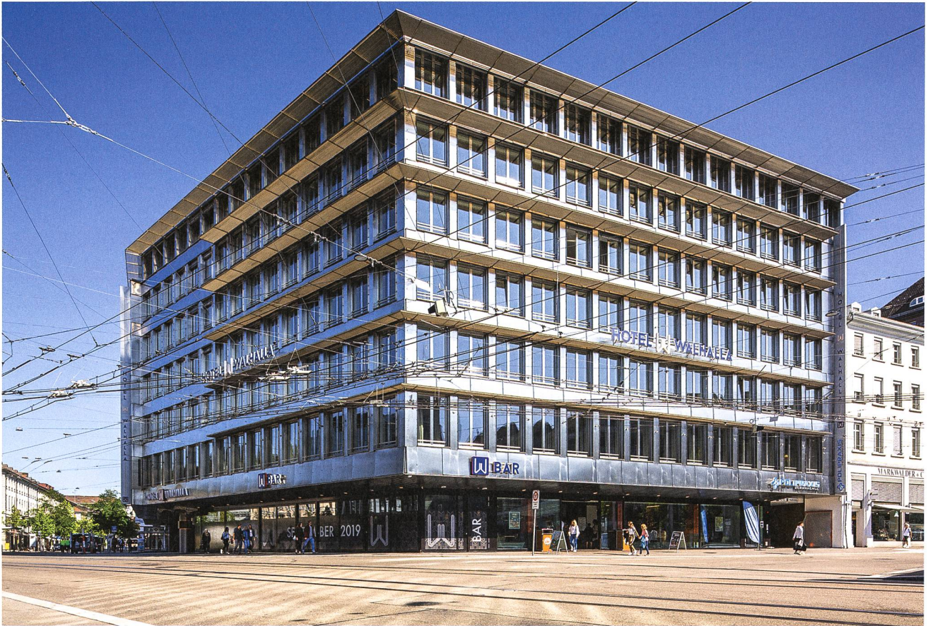
Die Fassade des Hotels Walhalla stammt von einem Umbau im Jahr 1994 von Architekt Jörg Quarella. Sie wurde lediglich gereinigt, bei den Fenstern wurde nur die Verglasung ausgetauscht, so dass sie in neuem Glanz erstrahlt. Foto: Patrick Armbruster.
