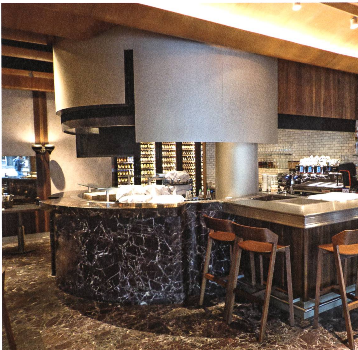
Oben: Die von Flugasbest gereinigte Bugholzdecke und der aufgefrischte und teils ergänzte Marmorboden binden die neu gestaltete Lobby und den alten Restauraanraum zusammen. Foto: Patrick Armbruster.
