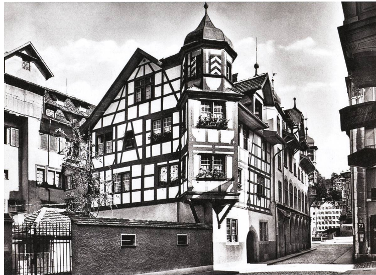
Aufnahme um 1906 mit wohl rotbrauner Riegelfassung. Quadratisch im Grundriss weist der Portnerhof über dem massiv gemauerten Erdgeschoss zwei Obergeschosse in Fachwerk auf und präsentiert an der Nordwestecke einen malerischen Eckerker, der im Dachbereich von einem achteckigen Türmchen gekrönt wird. Foto: Sammlung Uhler/Denkmalpflege Stadt St. Gallen.
