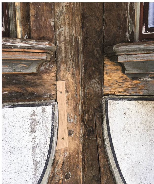
Musterstelle der durchgeführten Massnahmen. Schadhafte Holzpartien mit Echtholz-Vierungen ersetzt, rissiger und schuppiger Farbanstrich durch Schleifen entfernt, grobe Risse mit Ölkitt geschlossen. Foto: Denkmalpflege Stadt St. Gallen.
