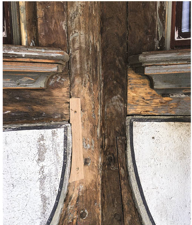
Musterstelle der durchgeführten Massnahmen. Schadhafte Holzpartien mit Echtholz-Vierungen ersetzt, rissiger und schuppiger Farbanstrich durch Schleifen entfernt, grobe Risse mit Ölkitt geschlossen. Foto: Denkmalpflege Stadt St. Gallen.
