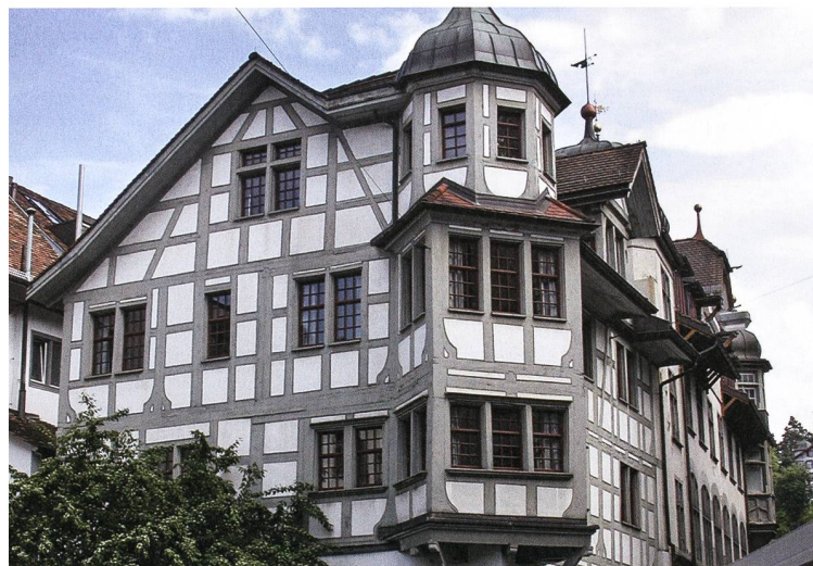
Aufnahme vor der Renovation 2019. Obwohl die letzte Fassadenrenovation fast 40 Jahre zurückliegt, sind das Riegelwerk und die verputzten Füllungen in einem guten Zustand erhalten, so dass sich die Unterhaltsarbeiten auf die wenigen Schadstellen im Riegelwerk und Verputz sowie einen neuen Farbauftrag auf dem Holz- und Mauerwerk beschränken konnte. Foto: Denkmalpflege Stadt St. Gallen.
