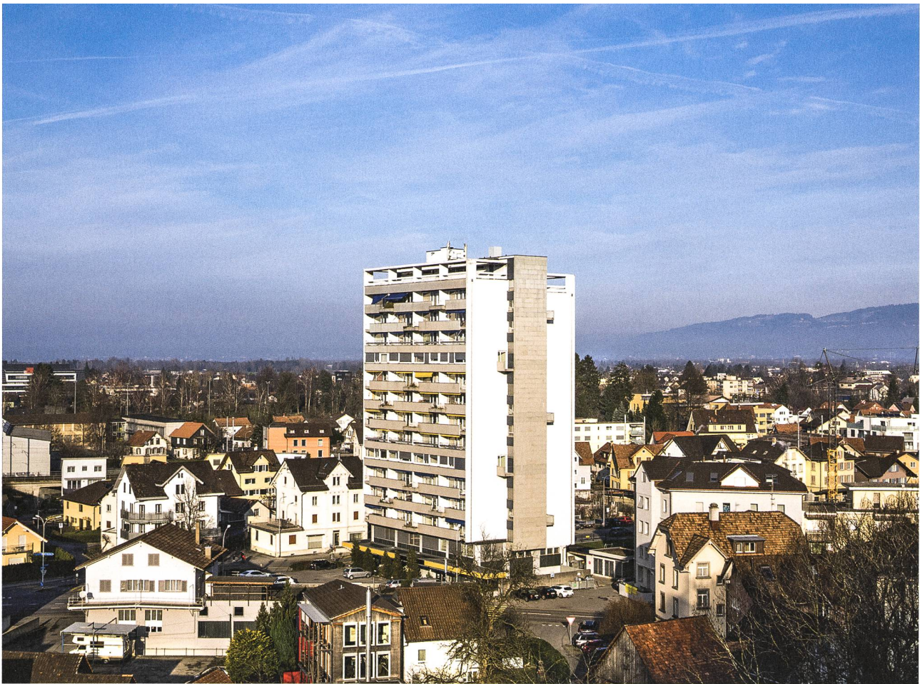
Das Scheibenhochhaus in St. Margrethen bleibt in seiner direkten Umgebung ein Fremdkörper. Man muss dieses Haus in einem grösseren Zusammenhang verstehen: es markiert die Grenze der Schweiz und die nordöstliche Ecke des Kantons.
