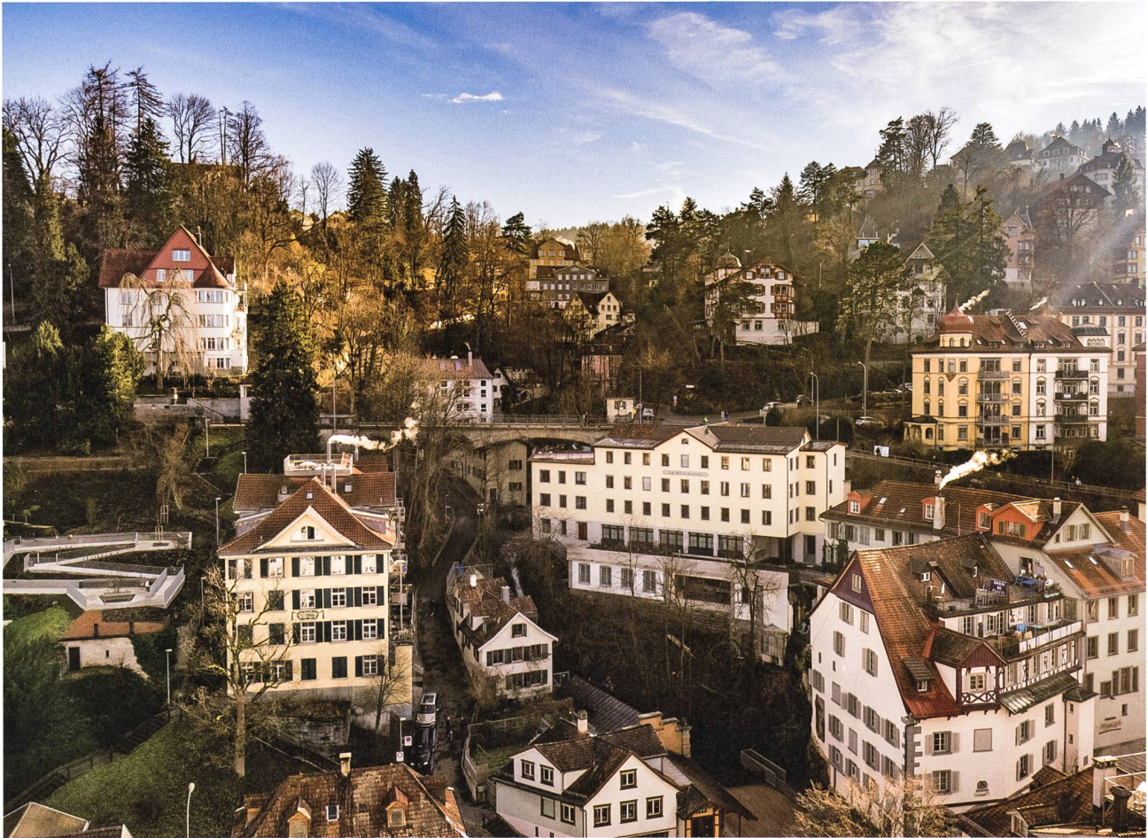
Im Mühlegg-Tobel in der Stadt St. Gallen treffen frühe Industriebauten und Erschliessungsbauwerke aufeinander. Die Brücken und Stützmauern sind Teil der städtischen Infrastruktur, die Bauten Zeugen der Industrialisierung. Auch hier spielt Höhe eine entscheidende Rolle.
