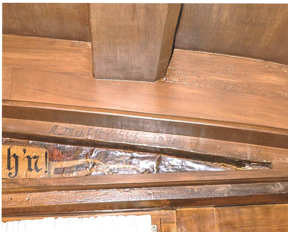
Ansicht nach Abschluss der Arbeiten. Zu erkennen sind die Aufdopplung zum Schutz der Balkenköpfe und die ergänzte Fassung der Maserierung.
