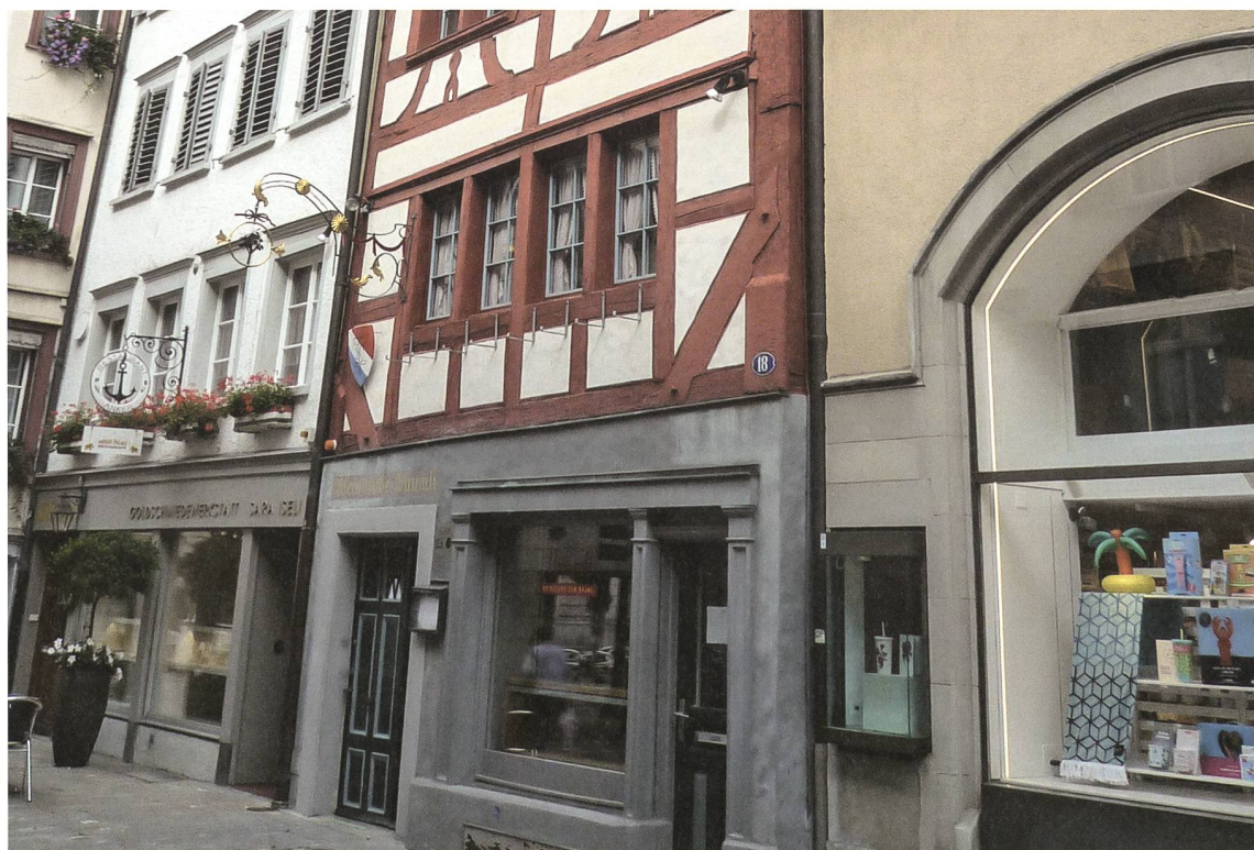
Riegelfassade des Bäumli wie sie bei der Renovation 1976 wieder hervorgeholt und restauriert wurde. Zu erkennen ist die leichte Ausbuchtung über dem Reihfenster im 1. Obergeschoss, welche wohl massgeblich für den nun behobenen Bauschaden verantwortlich war.
