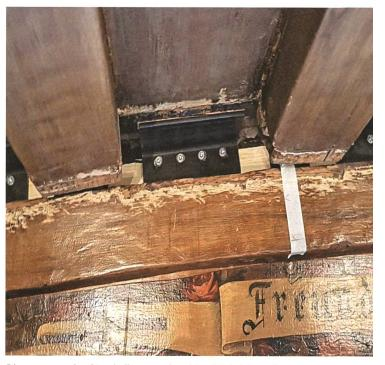
Die neuen, an den Sturzbalken verschraubten Winkeleisen dienen als eigentliche Auflager für die Dielen und indirekt auch für die Bälkchen, da diese mit den Dielen vernutet sind.
