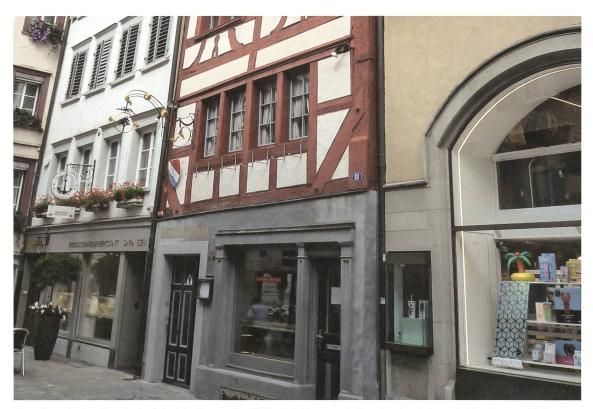
Riegelfassade des Bäumli wie sie bei der Renovation 1976 wieder hervorgeholt und restauriert wurde. Zu erkennen ist die leichte Ausbuchtung über dem Reihenfenster im 1. Obergeschoss, welche wohl massgeblich für den nun behobenen Bauschaden verantwortlich war.
