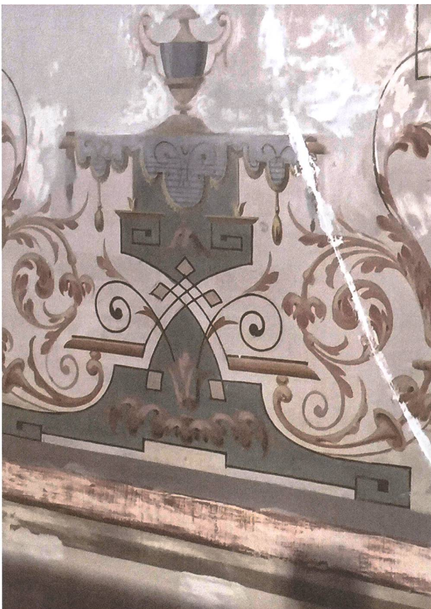
Zustand nach dem Entfernen der losen Farbe und dem Anschleifen des Untergrunds, vor dem Retuschieren.
