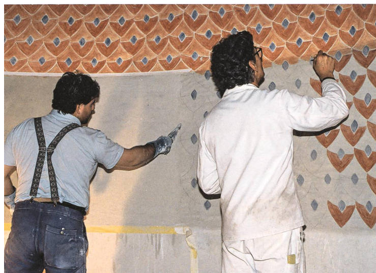
Erstellen eines Kalkfresko in der kath. Pfarrkirche Männedorf. Gemalt wird mit in Wasser angeteigten Pigmenten direkt in den noch frischen und feuchten Kalkputz. Verputzauftrag und Ausmalung erfolgen Hand in Hand. Die Technik ist daher nicht nur künstlerisch und fach-technisch sondern auch ablauftechnisch und organisatorisch anspruchsvoll.
