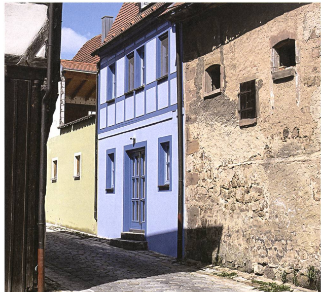
Das «blaue Gebäude». Das in zwei blauen Farbtönen gestrichene Fachwerkhaus im Brandenburgischen nimmt im weitesten Sinne Bezug auf die traditionelle Gestaltung von hellen Putzaufmachungen und einem hierzu farblich abgesetzten Holzfachwerk. Trotz allem wirkt die Fassade irritierend und falsch. Einerseits durch die optisch dichte und leuchtende Oberflächenwirkung der hier verwendeten Dispersionsfarbanstriche selber wie auch durch die intensiven Blautöne. Mindestens zur Bauzeit dieses Gebäudes hätte sich nur ein König oder Papst eine so blaufarbige Fassade kostenmässig leisten können.
