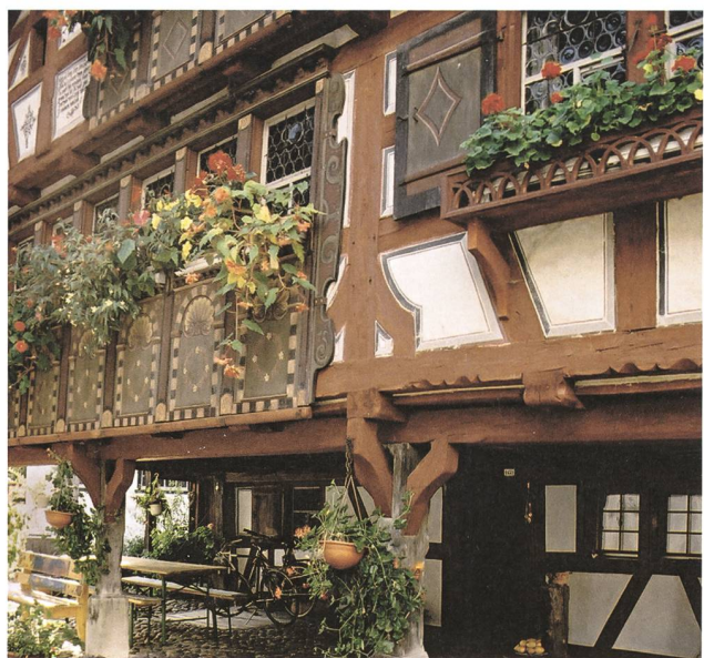
Farbe als Distinktion. Das alte Rathaus in Burgau hebt sich aus den umliegenden, holzsichtigen Strickbauten als farbig gefasster Fachwerkbau hervor und betont damit seine öffentliche Funktion. Foto Kantonale Denkmalpflege / Moritz Flury-Rova
