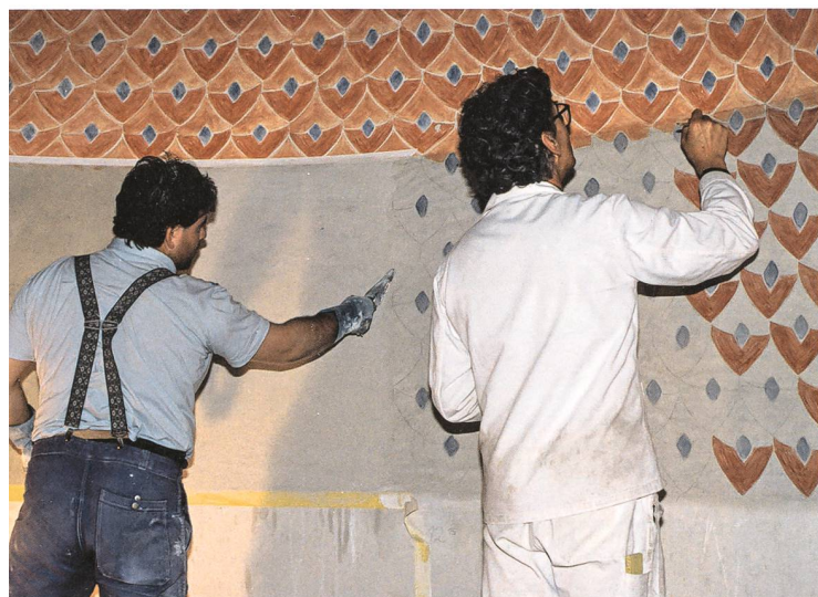
Erstellen eines Kalkfresko in der kath. Pfarrkirche Männedorf. Gemalt wird mit in Wasser angeteigten Pigmenten direkt in den noch frischen und feuchten Kalkputz. Verputzauftrag und Ausmalung erfolgen Hand in Hand. Die Technik ist daher nicht nur künstlerisch und fach-technisch sondern auch ablauftechnisch und organisatorisch anspruchsvoll.
