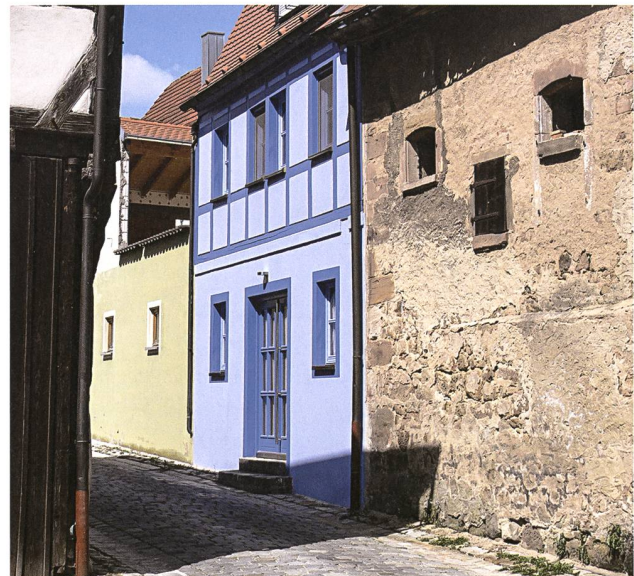
Das «blaue Gebäude». Das in zwei blauen Farbtönen gestrichene Fachwerkhaus im Brandenburgischen nimmt im weitesten Sinne Bezug auf die traditionelle Gestaltung von hellen Putzausfachungen und einem hierzu farblich abgesetzten Holzfachwerk. Trotz allem wirkt die Fassade irritierend und falsch. Einerseits durch die optisch dichte und leuchtende Oberflächenwirkung der hier verwendeten Dispersionsfarbanstriche selber wie auch durch die intensiven Blautöne. Mindestens zur Bauzeit dieses Gebäudes hätte sich nur ein König oder Papst eine so blaufarbige Fassade kostenmässig leisten können.
