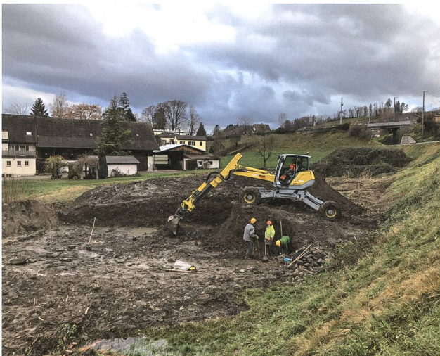
Rapperswil-Jona, Kempraten, Seewiese. Durchsuchen und Umbeigen des grossen Aushubhaufens. Aufnahme KASG.
