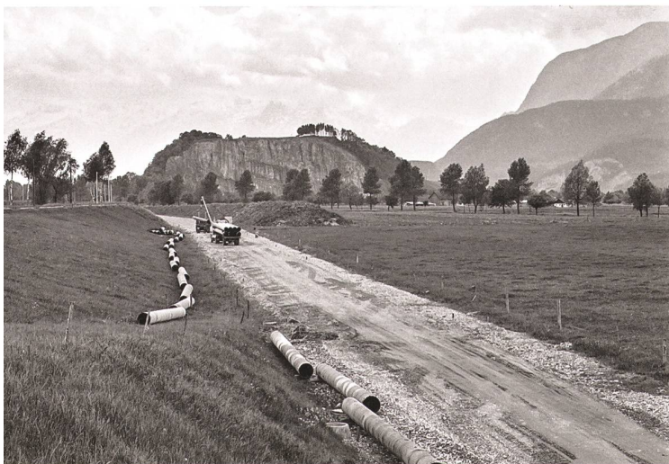
Links: Eine Baupiste – aber wo genau und wozu? Das Bild könnte aus dem Rheintal stammen. Beim genaueren Hinsehen ist links eine Mastenreihe auszumachen, das spricht für das Trasse der Dienstbahn der Internationalen Rheinregulierung bzw. die Steinbruchbahn bei Montlingen. Diese Bahn verläuft typischerweise auf dem Hochwasserdamm des Alpenrheins. Mit dem Bild wird der Bau der ENI-Ölpipeline hart am Dammfuss festgehalten, was mit dem Aufnahmezeitraum 1961 übereinstimmt. Slg. Bildarchiv ETHZ.
