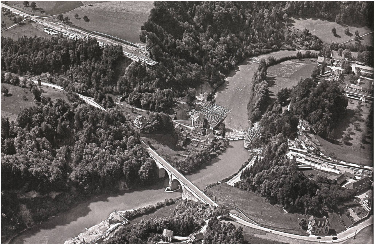
Der Bau des Fächergerüsts der Fürstenlandbrücke mit der Kräzern-Strassenbrücke im Vordergrund, 1938. 64
