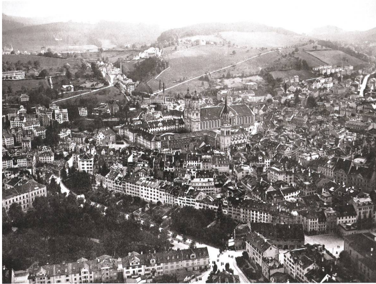
Spelterinis Flugaufnahme (zwischen 1882 und 1891) zeigt die Stadt St. Gallen Richtung Süden. Im Vordergrund befindet sich das Brühl-tor. Im Bildhintergrund ist die Berneggstrasse erkennbar, die noch über den ganzen Bernegg verlief. 26
