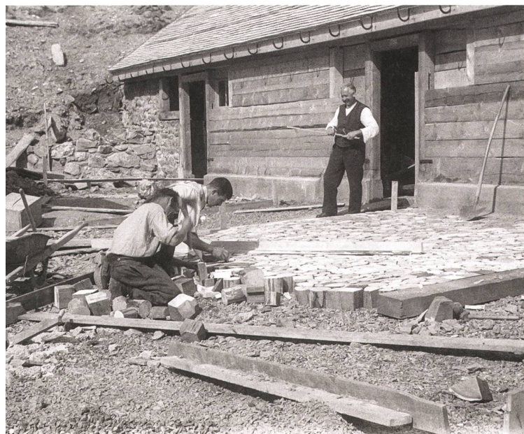
Volkswirtschaftsdepartement, Meliorationsamt: Pfäfers, Alp Calfeisen (Malanseralp), Obersäss: Handwerker beim Erstellen der Holzpflesterung zwischen den Ställen, Foto A. Scherrer, 1932 (StASG, ZOE 001/084).
