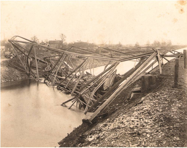
Bildarchiv der Rheinkorrektion, Werdenberger Binnenkanal: Eingestürzte Brücke bei Salez, Foto unbekannter Urheber, ca. 1885 (StASG, A 481/08.04): Da professionelle Fotografen ihre Urhebererschaft bei Fotos in aller Regel nachwiesen und dieser Beleg beim vorliegenden Dokument fehlt, kann man annehmen, dass ein Mitarbeiter der Rheinregulierung dieses Foto aufgenommen hatte.
