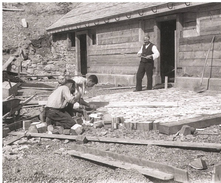
Volkswirtschaftsdepartement, Meliorationsamt: Pfäfers, Alp Calfeisen (Malanseralp), Obersäss: Handwerker beim Erstellen der Holzpflesterung zwischen den Ställen, Foto A. Scherrer, 1932 (StASG, ZOE 001/084).
