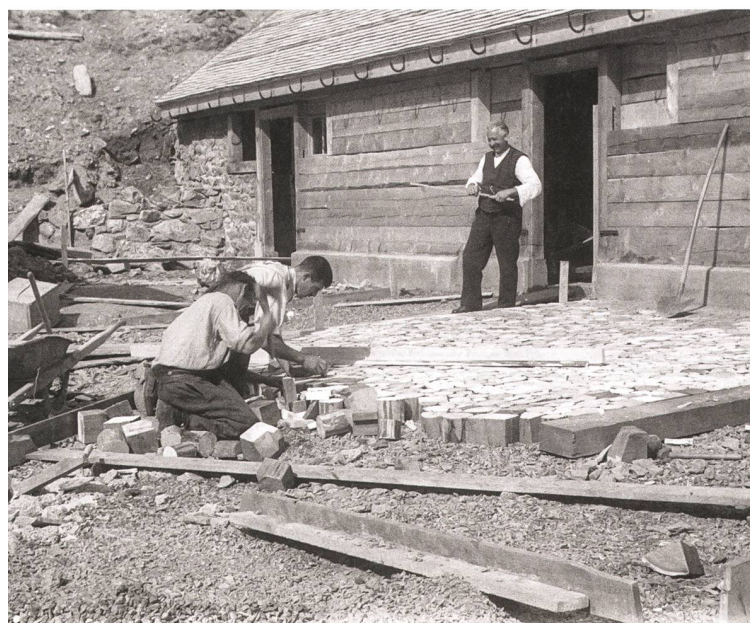
Volkswirtschaftsdepartement, Meliorationsamt: Pfäfers, Alp Calfeisen (Malanseralp), Obersäss: Handwerker beim Erstellen der Holzpflasterung zwischen den Ställen, Foto A. Scherrer, 1932 (StASG, ZOE 001/084).
