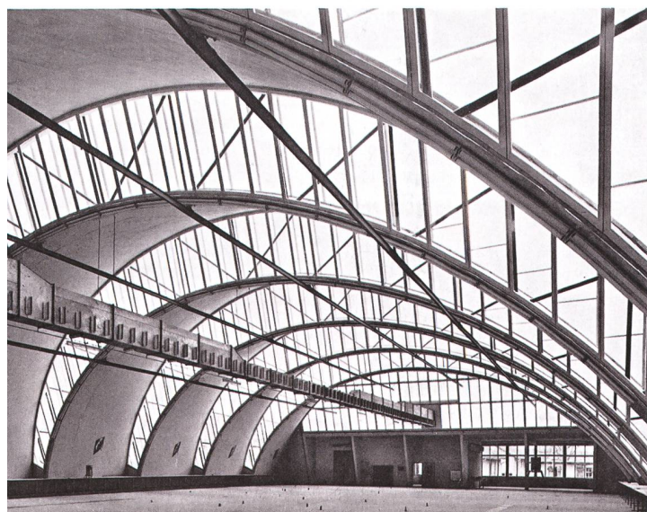
Die ehemalige Gummibandweberei Gossau, erbaut 1954–1955 von Danzeisen und Voser, wurde in die Architektursammlung des Museums of Modern Art in New York aufgenommen. Foto aus: Werk 43, 1956, S. 49.
