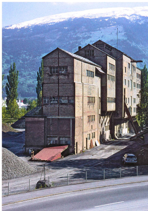
Aufbereitungsanlage Malerva, Sargans. Hier wurde das Eisenerz aus dem Gonzen gebrochen, klassifiziert und sortiert direkt auf Eisenbahnwagen verladen. Foto: Kantonale Denkmalpflege 2005.
