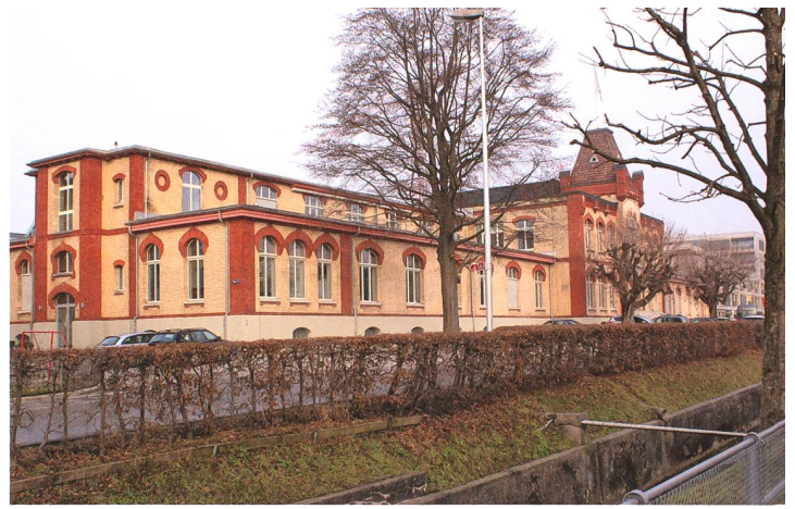
In der ehemaligen Stickereifabrik Alder & Rappolt, Gossau, erbaut 1900 und 1906/1907 von Wendelin Heene, befinden sich heute ein Gastronomiebetrieb und die Stadtbibliothek. Foto: Kantonale Denkmalpflege.
