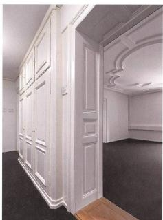
Bild oben: Vorhandene originale Bauteile wurden restauriert und in das Raumkonzept integriert. Da, wo zum Beispiel die originalen Türen fehlten, sind diese durch zeitgenössische Produkte ergänzt worden. Aufnahme Jürg Zürcher.
