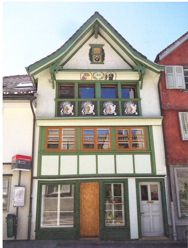
Gleiche Ansicht nach der Renovation mit der originalen Farbgebung (nach Befund).
