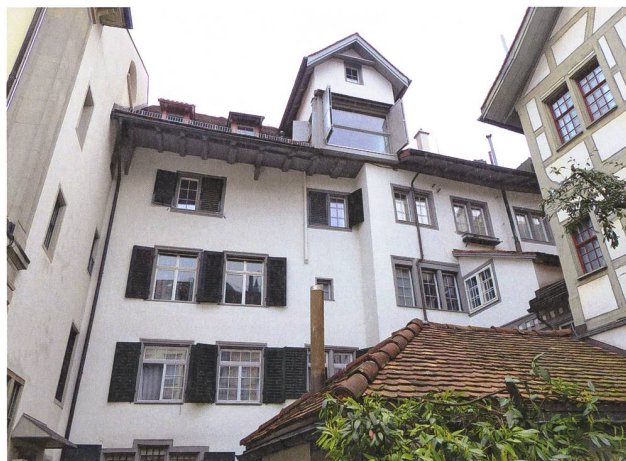
Die Gaube des ehemaligen Holzaufzugs wird zur Belichtung des grossen Dachraums neu genutzt.
