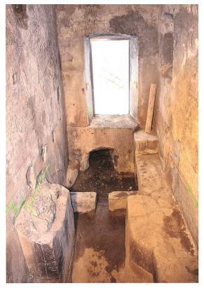
Ketthaus: Hier floss der Kanal durch und trieb ein Wasserrad an.
