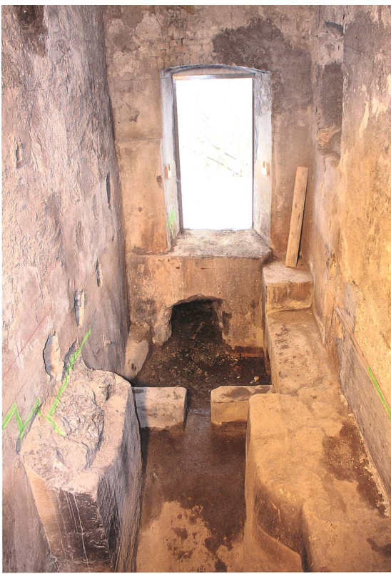
Ketthaus: Hier floss der Kanal durch und trieb ein Wasserrad an.
