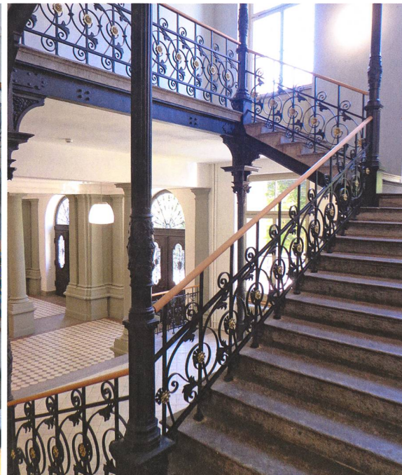
Treppenhaus vor (links) und nach (rechts) der Sanierung. Das Treppengeländer wurde nicht nur neu gestrichen, sondern mit einer unauffälligen Erhöhung zumindest teilweise auch an die heute gültigen Normen bezüglich Absturzsicherung angepasst.
