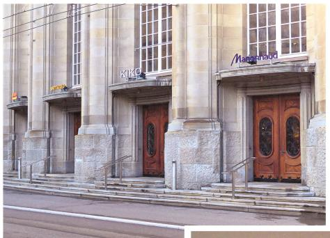
Bild links: Dank hochwertiger Ausführung und der technischen Aufrüstung konnten die originalen Türen und Fenster restauriert und erhalten werden.
