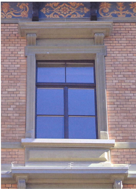
Beim Ersatz der sprossenlosen Fenster aus den 1960er-Jahren wurde das ursprüngliche Erscheinungsbild angestrebt.
