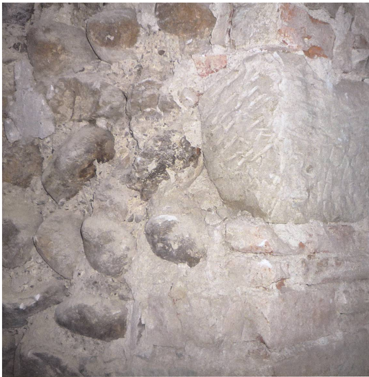
Im Erdgeschoss fügen sich Mauerreste aus verschiedenen Jahrhunderten zusammen. Die teilweise russgeschwärzten und versengten Bollensteine lassen eine Bauzeit vor dem grossen Stadtbrand 1418 vermuten.
