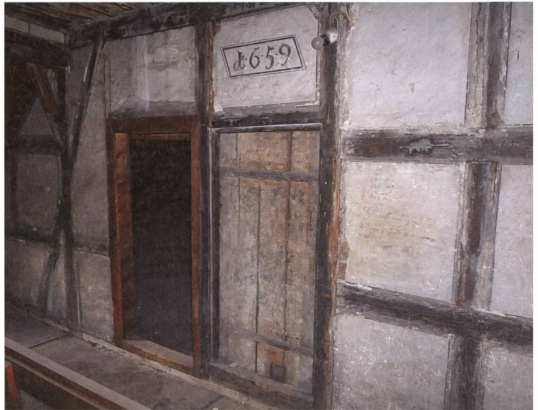
Im Erdgeschoss fügen sich Mauerreste aus verschiedenen Jahrhunderten zusammen. Die teilweise russgeschwärzten und versengten Bollensteine lassen eine Bauzeit vor dem grossen Stadtbrand 1418 vermuten.
