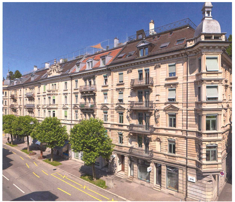
Dank einer grundsoliden Bauweise konnte auf eine Fassadenrenovation verzichtet werden. Aus Schallschutzgründen wurden aber die rund 30-jährigen Fenster durch neue, dem ursprünglichen Bestand angepasste Holzfenster ersetzt. Aufnahme Jürg Zürcher.
