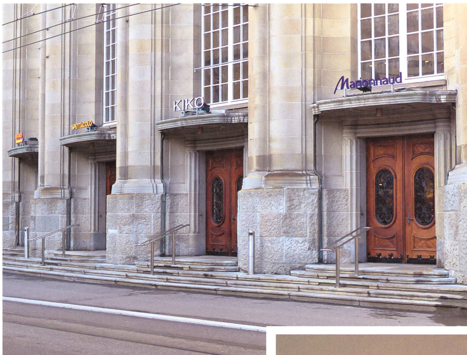
Bild links: Dank hochwertiger Ausführung und der technischen Aufrüstung konnten die originalen Türen und Fenster restauriert und erhalten werden.
