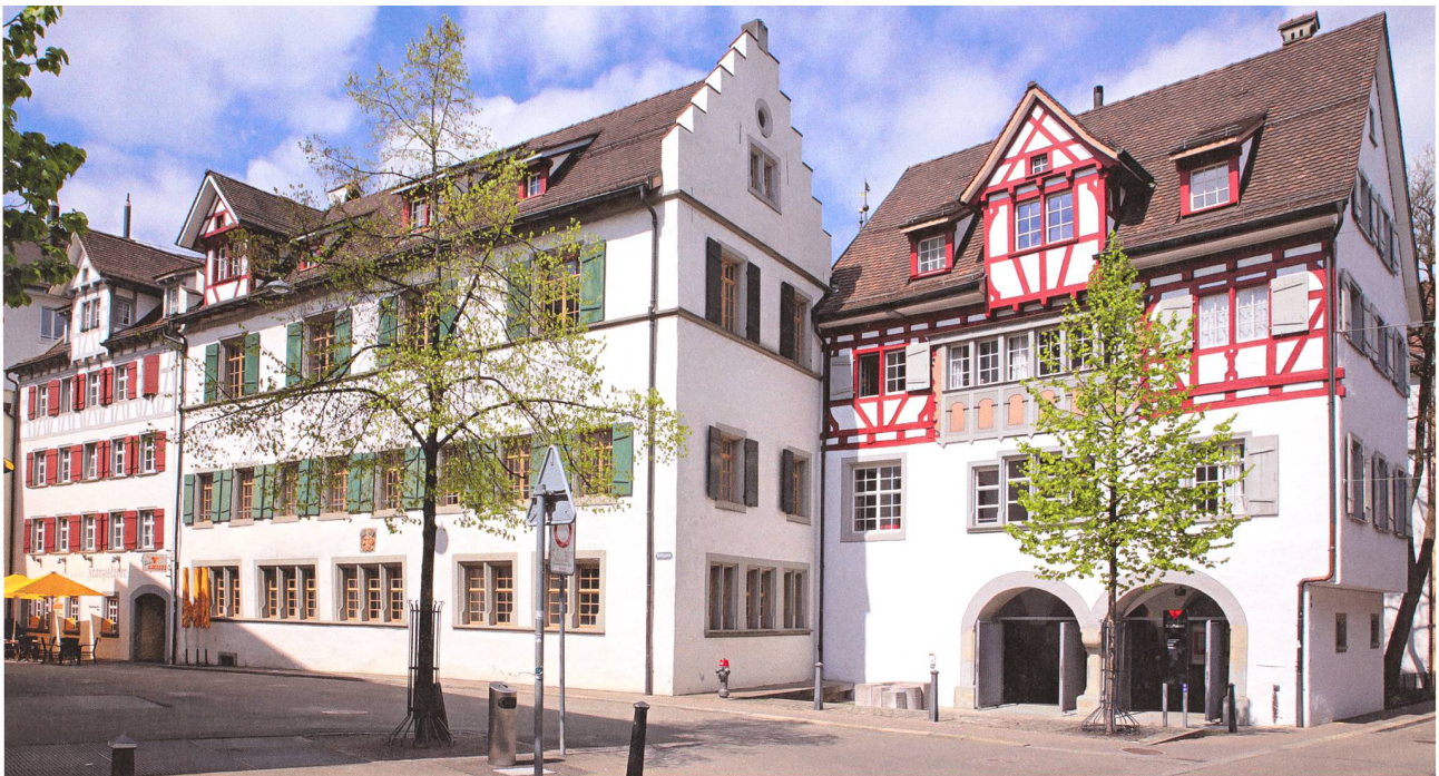
St. Gallen. Frontgebäude des ehemaligen Dominikanerinnenklosters St. Katharina. Das Kloster wurde infolge der Reformation aufgehoben, und von den Nonnen wurden 1594 die Gebäude der Stadt verkauft. Aufnahme 2017, Johannes Huber, St. Gallen.
