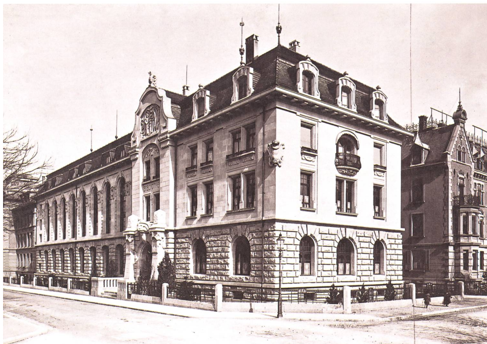
Stadtbibliothek Vadiana. In den hohen, eng geschalteten Rundbogenfenstern des östlichen Gebäudeabschnitts, aber auch im Risalit und seinem Schweifgiebel, erinnert der Bibliotheksbau an das Schiff der Kathedrale St. Gallen (hier in Ost-West-Ausrichtung). Andere Stilitate, beispielsweise der Sockel in Rustika (Bossenwerk), evozieren die italienische Renaissance – per se eine Signalepoche, die für «Aufbruch» steht (in allen Bedeutungen dieses Worts). Im westlich gestellten Kopfbau konzentrieren sich Wissen, Geist und Forschung. Als Bau und Funktionsort scheint die Vadiana institutionell das zu sein, was sich vielleicht auch schon Vadian unter – dem provokativen Titel – einer (profanen) Kathedrale vorgestellt hätte. Aufnahme um 1908. Quelle: Kantonsbibliothek Vadiana St. Gallen, VadSlg SA F 194.
