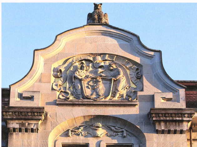
St. Gallen, Notkerstrasse 22. Kantonbibliothek Vadiana St. Gallen, die ehemalige Stadtbibliothek Vadiana. Schweifgiebel mit Relief des Stadtwappens und bekrönender Eule. Die Eule ist das Sinnbild der Weisheit (und Literatur); das Tier, am und im Gebäude der Vadiana mindestens dreimal angebracht, sollte sich auch in Forschern, etwa dem eulenhaft wirkenden Bibliothekar Johannes Dierauer, personifizieren. Aufnahme 2017, Johannes Huber, St. Gallen.
