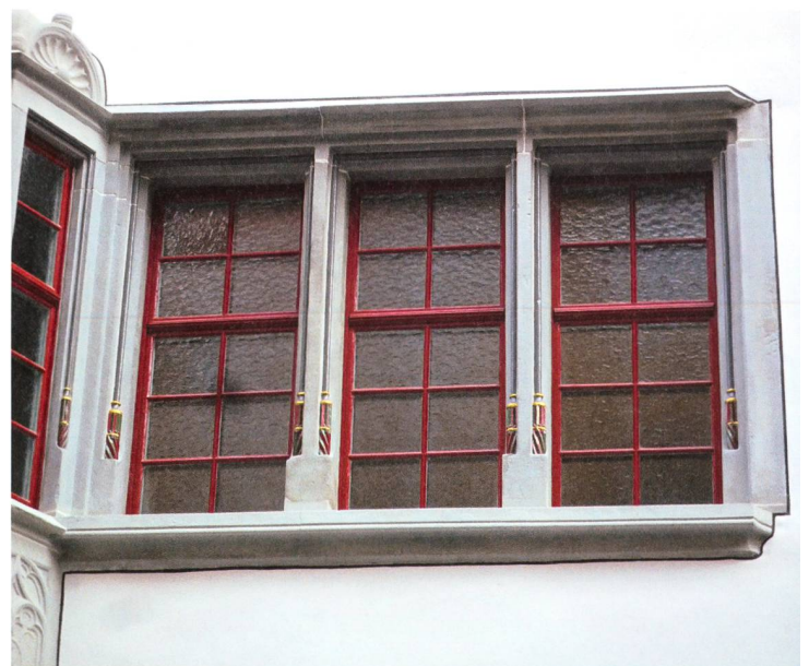
Spätgotische Reihenfenster aus der Bauzeit um 1580 mit Kehlen und Rundstäben profiliert, welche aus geschraubten und mit Perlschnüren besetzten Basen wachsen.
