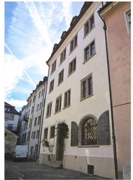
Hoffassade nach der Renovation 2016.
