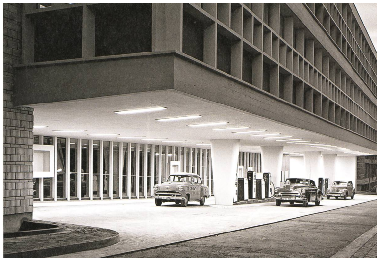
Jahresausstellung 2016: Architektur der Nachkriegszeit der Stadt St. Gallen (Tankstelle Centralgarage).
