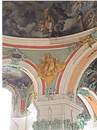
Die Reinigung der Deckenmalereien erfolgt mit Feinhaarpinsel und Feinstaubsauger. Die rechte Bildhälfte ist hier noch in ungereinigtem Zustand.
