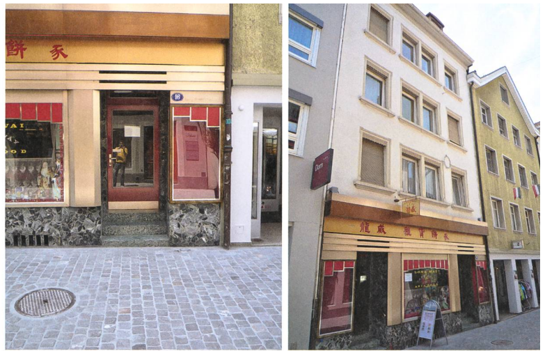
...2011: Durch das Hinzufügen verschiedener materialfremder Dekorelemente ist die architektonische Wirkung verloren gegangen und austauschbar geworden.
