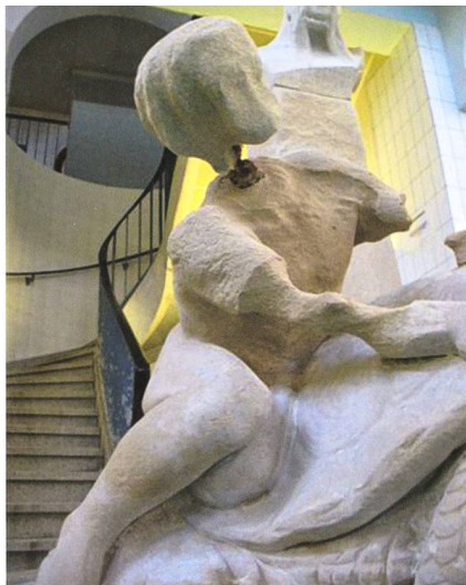
Die durch eindringendes Chlorwasser stark zerfressenen Skulpturen mussten aus Sicherheitsgründen entfernt werden.
