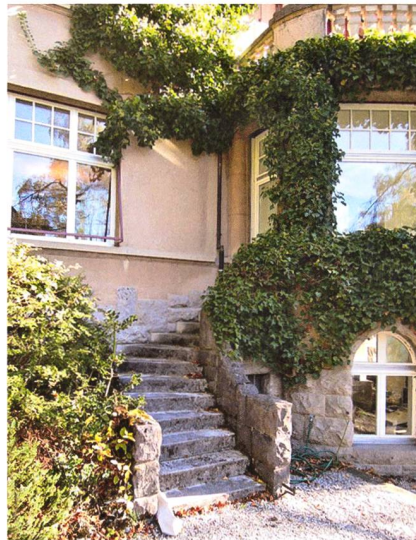
Der Efeubewuchs war zwar durchaus maleirisch, hatte jedoch bereits den Putz angegriffen und musste entfernt werden. Bild vor der Sanierung.
