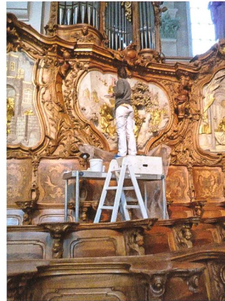
Die Statuen und Reliefs wurden im Trockenverfahren gereinigt. Danach folgte eine feucht-trockene Nachreinigung.
