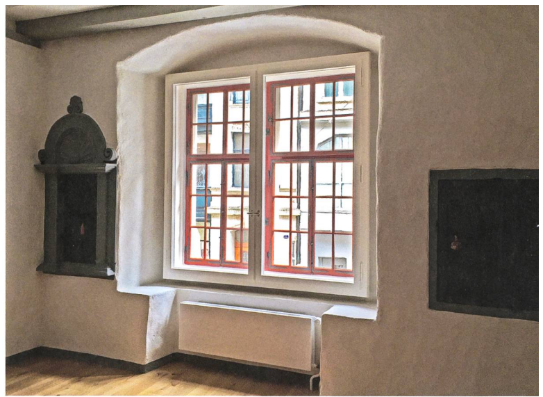
Dort, wo heute die Küche ist, war ursprünglich wahrscheinlich der Geschäftsraum des Hauses untergebracht. Beidseits des grossen Kastenfensters in der Fensternische sind Wandtresore eingebaut.
