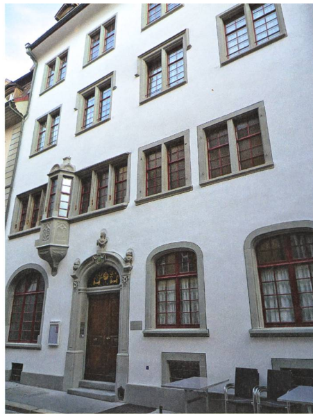
Gassenfassade nach der Renovation 2016.
