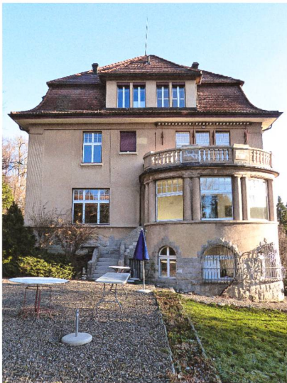
Die Westfassade nach der Entfernung des Efeus und der lokalen Ergänzung des ursprünglichen, glimmerhaltigen Verputzes.
