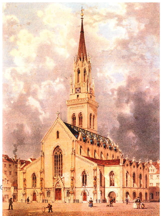
Bild unten: Das Gotteshaus nach dem Umbau von 1850–1854, Aquarell von L. Graf 1858.
