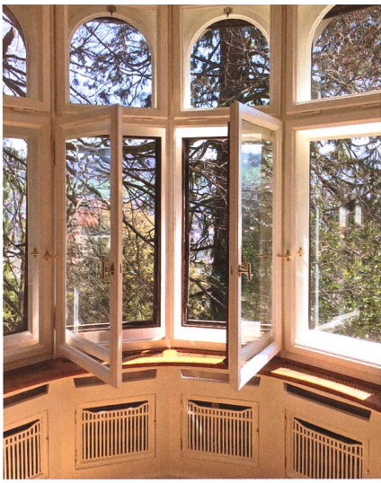
Der sonnendurchflutete Erker zur Stadt hin glänzt nun wieder in seiner ursprünglichen Materialisierung und Farbgebung.
