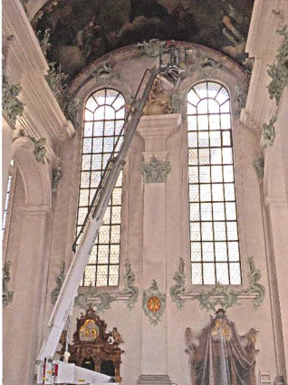
Um den ordentlichen Betrieb der Kathedrale nicht zu beeinträchtigen und ein kostspieliges Gerüst zu vermeiden, wurde mit mobilen Hebebühnen gearbeitet.
