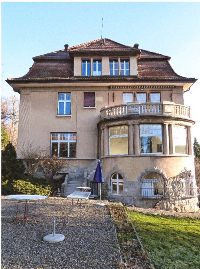
Die Westfassade nach der Entfernung des Efeus und der lokalen Ergänzung des ursprünglichen, glimmerhaltigen Verputzes.
