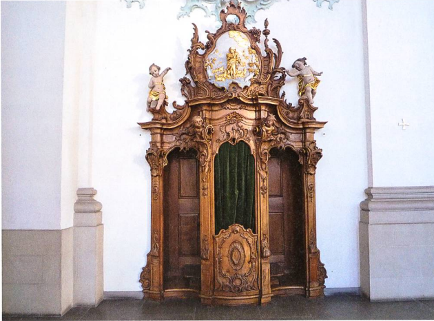
Restaurierter Beichtstuhl, es ist nur noch für das geübte Auge ein Unterschied zwischen dem linken, unversehrten Flügel und dem rechten, vom Brandfall betroffenen Flügel zu erkennen.
