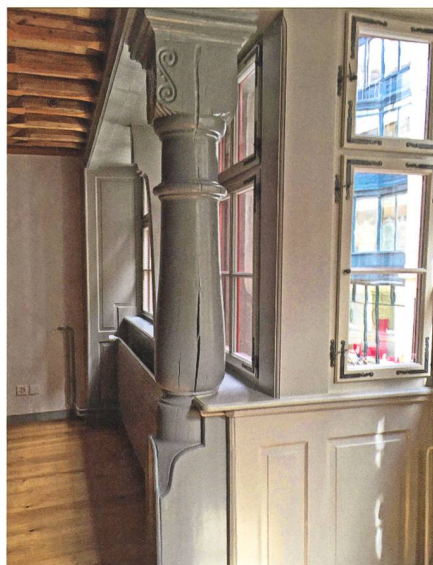
Bei der Erkernische befindet sich die mit Renaissance-Motiven geschmückte Fenstersäule aus dem Jahre 1666.
