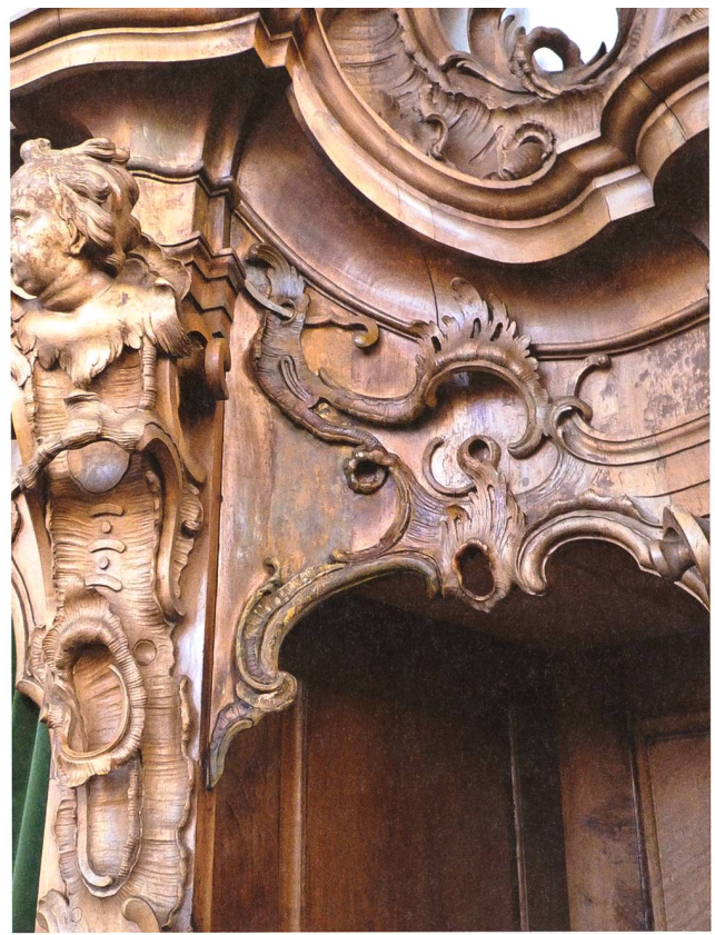
Neben den Brandschäden, welche hier bereits weitgehend entfernt sind, bilden frühere Kittungen bei den Wurmgehängen eine starke optische Beeinträchtigung.
