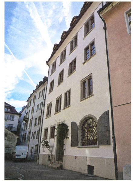
Hoffassade nach der Renovation 2016.
