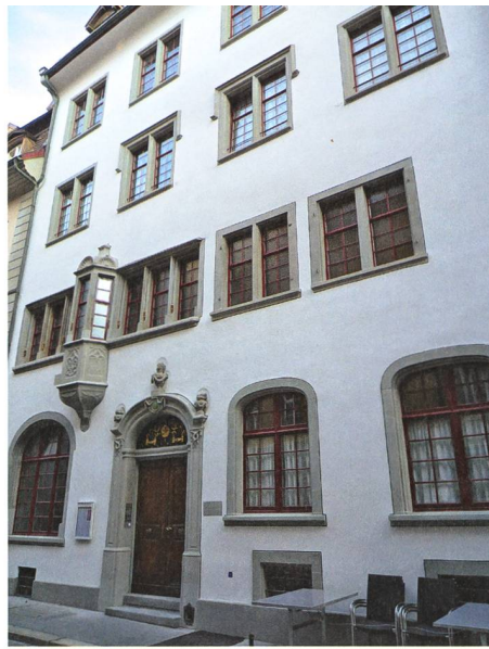
Gassenfassade nach der Renovation 2016.
