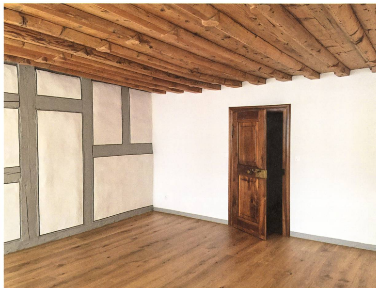
Die charakteristische Balkendecke der Wohnstube ist mit herzförmigen Ausläufern und leeren Schildern in der Mitte ausgestattet. Bei der sorgfältigen Restaurierung von 1978 wurde auch der Innenriegel der Wand freigelegt.
