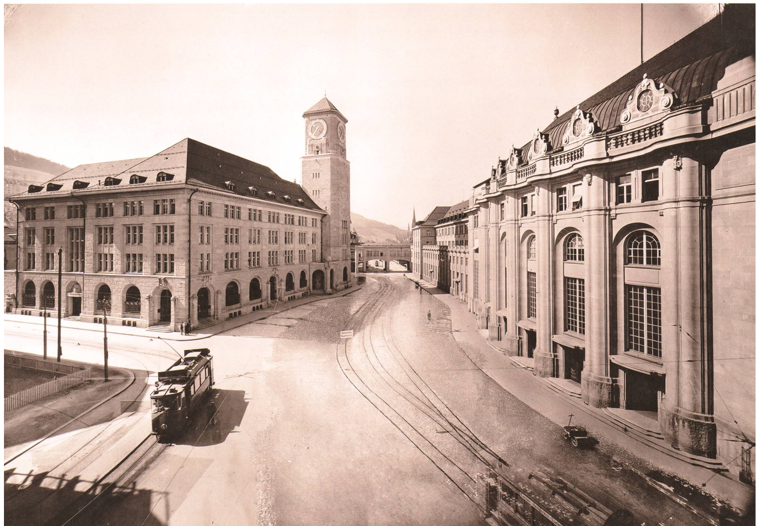
St. Gallen. Präsenz des Schweizerischen Bundesstaates am Bahnhofplatz, zugleich grossstädtische Empfangs- und Exportstation der Stickereimetropole. Hauptpost mit Postturm 1911–1915, Architekten: Pflegard & Haefeli, Zürich. Bahnhof SBB mit Architekturzitaten der Klosterkirche St. Gallen, 1911–1914, Architekt: Alexander von Senger, Ingenieur: Robert Maillart. Aufnahme um 1920. Eidgenössisches Archiv für Denkmalpflege, Graphische Sammlung Nationalbibliothek Bern.
