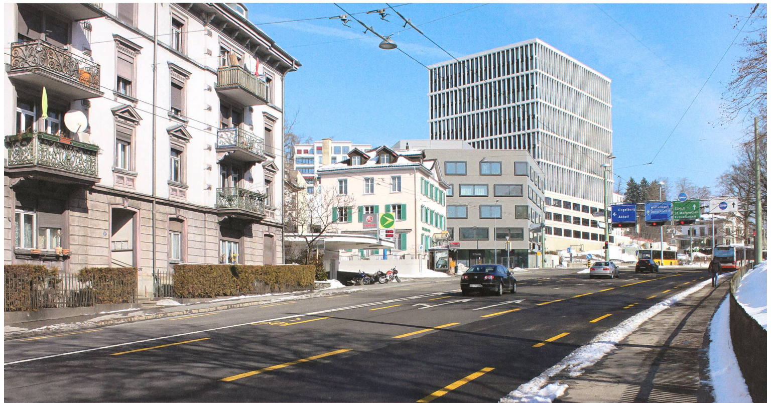
St. Gallen. Das Bundesverwaltungsgericht (BVG) thront wie eine Akropolis über dem Quartier Lachen und der stark befahrenen Zürcherstrasse. Wettbewerb 2005, Realisierung 2008–2012. Architekten: Staufer & Hasler, Frauenfeld. Bauherrschaft: Hochbauamt Kanton St. Gallen. Aufnahme: Peter Röllin.
