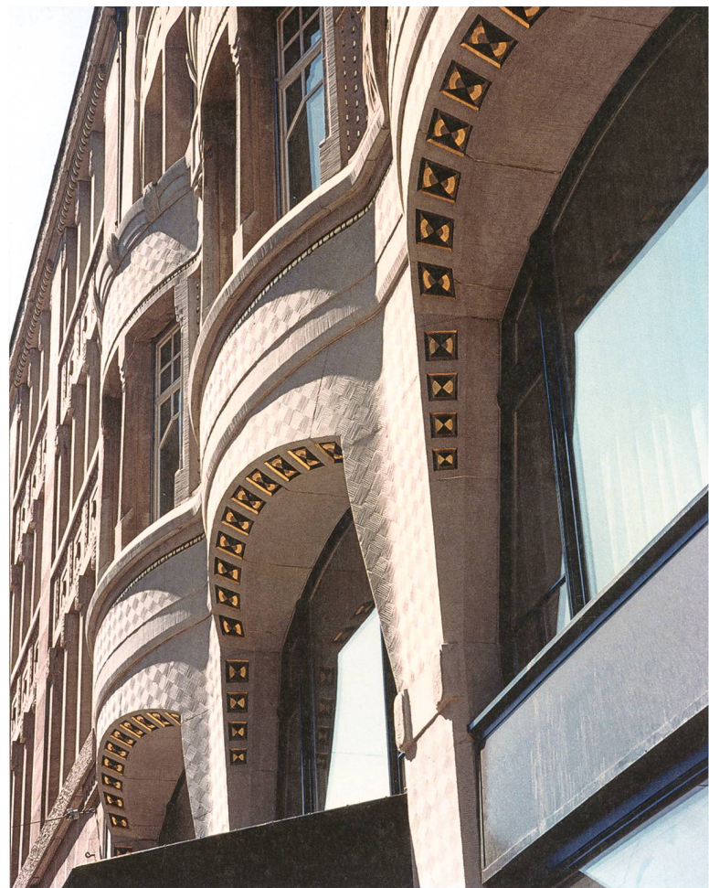
St. Gallen. Ehemaliges Stickereigeschäftshaus Oceanic mit Art Nouveau-Wellenschlag, St. Leonhard-Strasse, erbaut 1906. Architekten: Pflughard & Haefeli, Zürich, für Carl Fenkhart. Archiv Peter Röllin.
