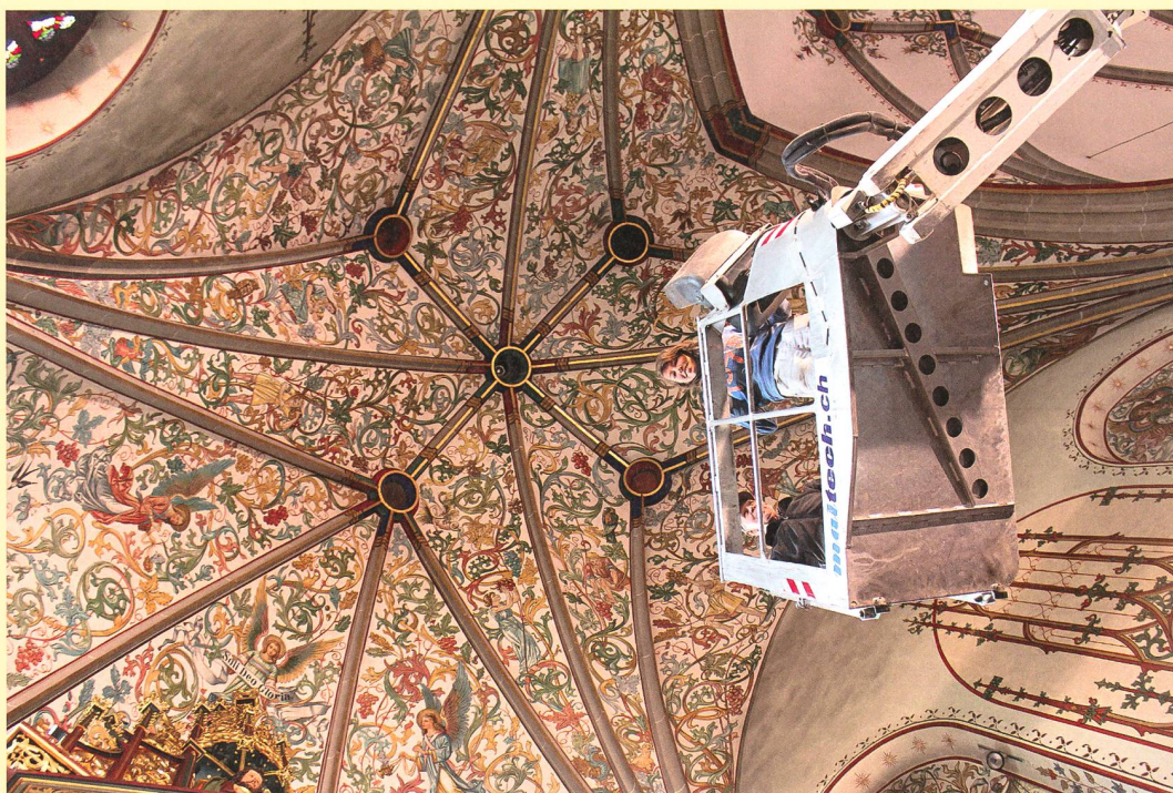
Gaiserwald, kath. Kirche St. Josef in Abtwil. Eine periodische Innenreinigung durch einen Restaurator (hier Johann Herovits, Goldach) dient dem Erhalt der reichen Ausmalung aus der Bauzeit 1905. Foto: Kantonale Denkmalpflege.
