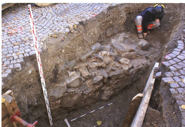
St. Gallen, Multergasse. Freilegungsarbeiten am Vorwerk des Multertors. Aufnahme: KASG.
