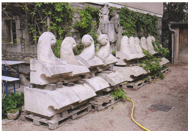
Masswerkblendbogen im Aufbau (links), gestapelte Krabben, Profilsteine und Wasserspeier. Werkstückpark mit dem Imaginationspotenzial eines mittelalterlichen Bauhüttenbetriebs. Vorhof des Doms von Regensburg (Deutschland). Aufnahmen 2015, Johannes Huber, St. Gallen.
