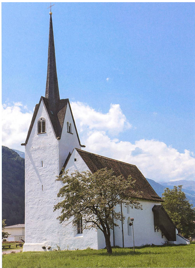
Ragaz. Kapelle St. Leonhard. Typus Siechenkapelle (Feldsiechen). Überrest einer ausserhalb der klösterlichen Verwaltungssiedlung gegründeten spätmittelalterlichen Absonderungseinrichtung, die zur Aufnahme von Aussätzigen aus dem Herrschaftsgebiet der Fürstabtei Pfäfers diente. Die Kranken gelangten vom Siechenhaus (abgegangen) über einen holzverschalteten, geschlossenen Zu- und Aufgang (am Schiff rechts sichtbar) auf die Empore. Aufnahme 2014, Johannes Huber, St. Gallen.
