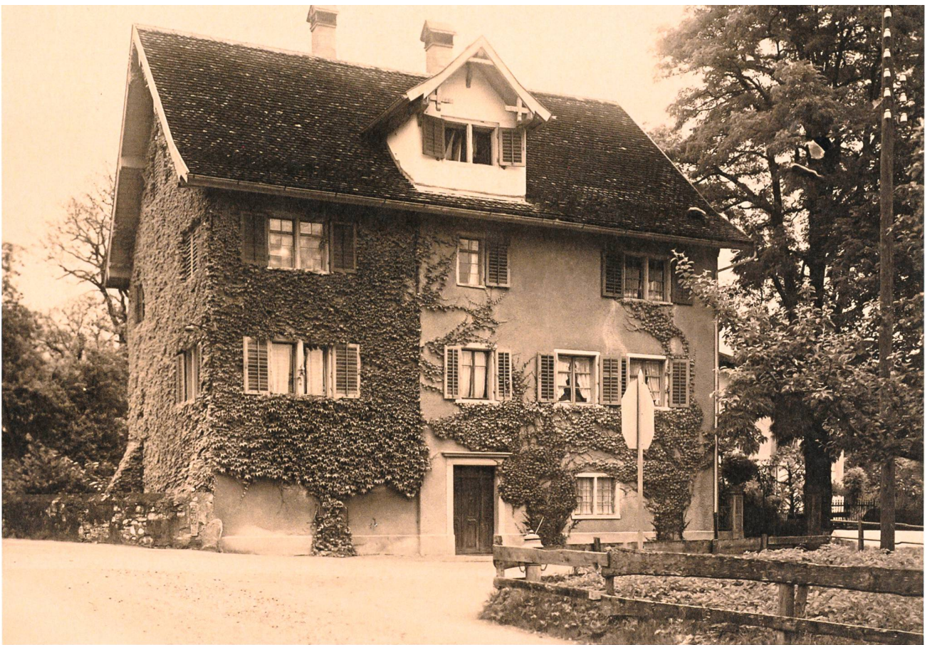
Grabs, Altes Pfarrhaus. Spätmittelalterlicher Habitus, mit baulichen Anpassungen des 16.–18. Jahrhunderts. Es handelt sich möglicherweise um das ehemalige Samnungsgebäude. Das Anwesen erfüllte sämtliche Voraussetzungen eines Beginenhauses: Nähe seines Standorts zur Kirche, Geräumigkeit (mehrere Stockwerke), Möglichkeiten zur räumlichen Separation, Speicherplätze (für Lebensmittel: Wirtschaftsräume im Erdgeschoss; Kornschütte im Dach), Nähe zum Dorf und den Menschen (praktische Seelsorge). Archiv Hansruedi Rohrer, Buchs.
