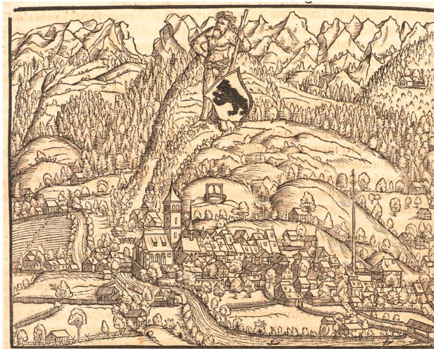
Dorf Appenzell. Holzschnitt, publiziert in der 1548 datierten Chronik des Johannes Stumpf, folglich zwei Jahre nach dem Tod Diepolt Huters. Der Baubestand des Dorfs entspricht weitgehend jener Situation, die auch Huter noch kannte. Dominant sind die Gebäude im Kirchenbezirk, nämlich Pfarrkirche und Beinhauskapelle. Quelle: Kantonsbibliothek Vadiana, St. Gallen, VHelv a 299_5Buch_90.
