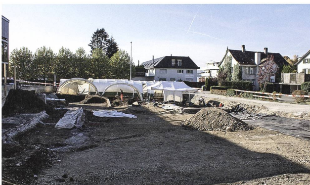
Rapperswil-Jona, Kempraten, Zürcherstrasse 108/110. Überblick über die Ausgrabung. Foto KASG.
