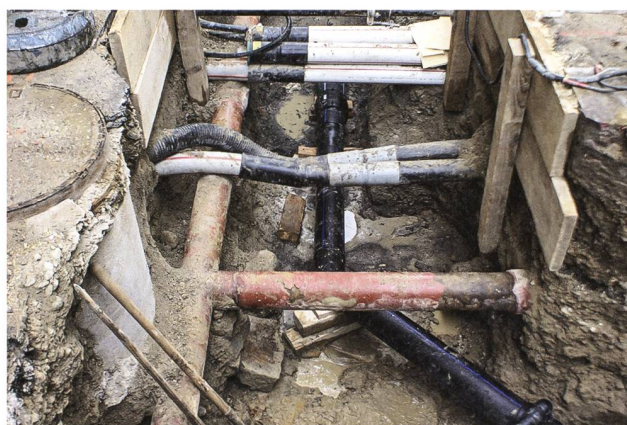
St. Gallen, Neugasse 40–43. Trotz Leitungsgewirr haben sich archäologische Reste erhalten. Foto KASG.
