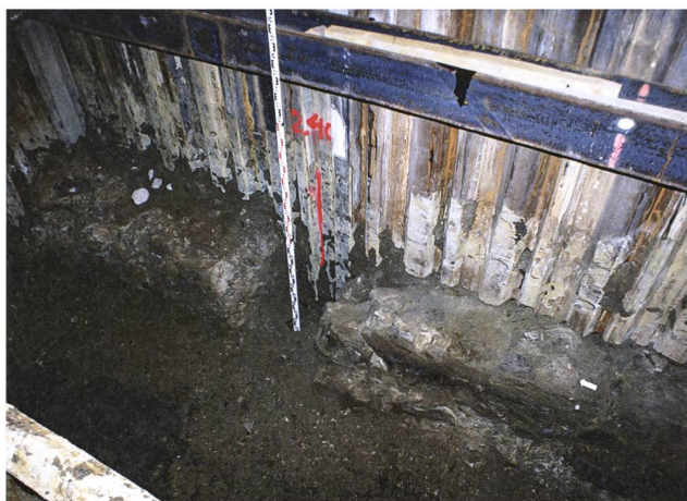
St. Gallen, Unterer Graben 1. Blick auf die Abbruchkante der Kontermauer. Foto KASG.
