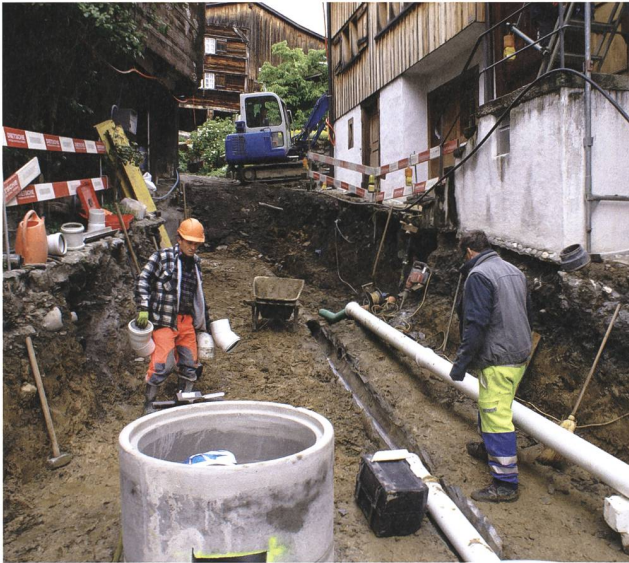
Grabs, Werdenberg. Die tief greifenden Leitungsbauten machten eine ständige archäologische Baubegleitung unumgänglich. Foto KASG.
