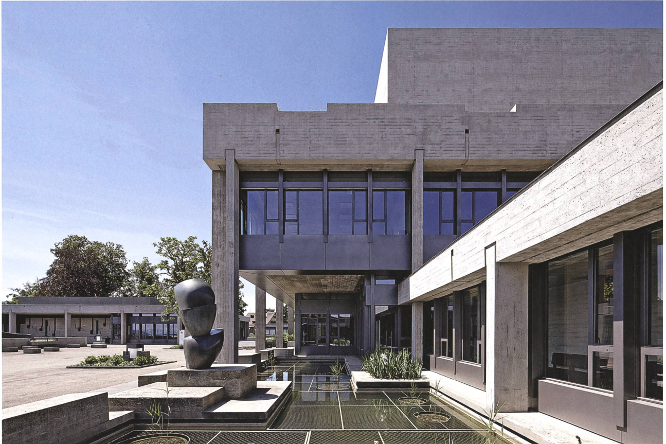
Mit den ausdrucksstarken, körperhaften Sichtbetonbauten der damaligen Handelshochschule St. Gallen schufen die Basler Architekten Förderer, Otto und Zwimpfer 1960–1963 auf dem Rosenberg ein unverwechselbares Baudenkmal. Gebäude, Aussenraum und die Skulptur von Hans Arp verschmelzen zu einem Gesamtkunstwerk. Foto: Hanspeter Schiess, Trogen.
