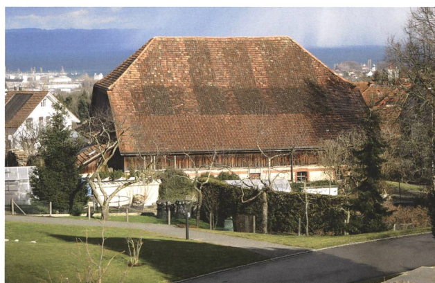
Ebenfalls in der Gemeinde Berg liegt diese Scheune, deren Dach durch die Mischung verschiedenster Ziegel eine wunderbare Lebendigkeit erhält. Steter Unterhalt ergibt eine schöne Wirkung. Foto: Kantonale Denkmalpflege St. Gallen.
