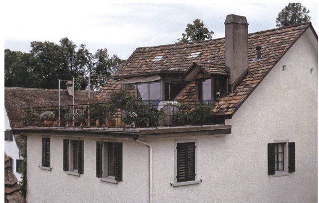
Das Haus am Endingerplatz in Rapperswil hatte bereits eine <Zinne> aus dem 19. Jahrhundert. Als 2000-2002 das Dach ausgebaut wurde, verstand es Architekt Felix Inglin, die Dachaufbauten so zurückhaltend und feingliedrig zu gestalten, dass sie die Dachlandschaft nicht beeinträchtigen. Foto: Kantonale Denkmalpflege St. Gallen.
