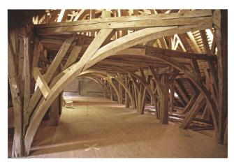
Der Dachstuhl, der die drei alten Flügel der Konventsbauten des Klosters Mariaberg in Rorschach überspannt, wurde kurz nach 1500 in berauschender Eleganz errichtet. Die Auswechslung einzelner schadhafter Hölzer ist an deren heller Farbe ersichtlich. Foto: Kantonale Denkmalpflege St. Gallen.
