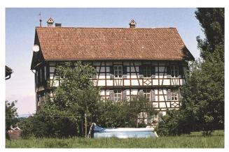
Der Gutshof des «Kleinen Hahnberg» (Berg SG) wies 2000 noch ein arg verwittertes, aber sehr seltenes Dach mit Mönchs- und Nonnenziegeln auf. Bei der Renovation wurden alle noch brauchbaren Ziegel auf die Schauseite versetzt, so dass in dieser Ansicht das alte Dach wieder intakt ist. Foto: Kantonale Denkmalpflege St. Gallen.
