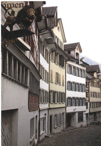
Die Löwengasse in Lichtensteig wird stark von den Aufzugserkern bestimmt, die immer wieder eine kurze Unterbrechung der Traufe bedingen. Sie sind eine willkommene Gelegenheit, Licht in die Dachräume zu bringen. Foto: Kantonale Denkmalpflege St. Gallen.
