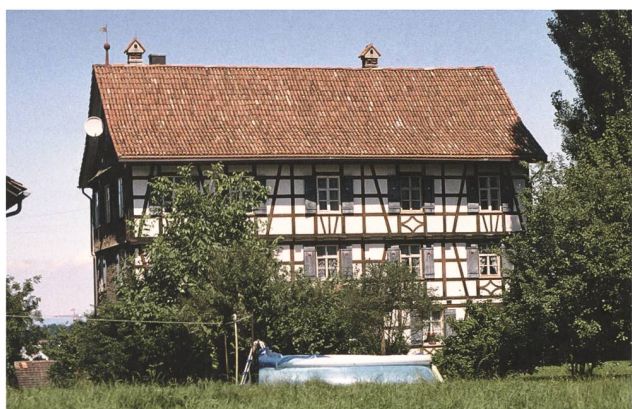
Der Gutshof des «Kleinen Hahnberg» (Berg SG) wies 2000 noch ein arg verwittertes, aber sehr seltenes Dach mit Mönchs- und Nonnenziegeln auf. Bei der Renovation wurden alle noch brauchbaren Ziegel auf die Schauseite versetzt, so dass in dieser Ansicht das alte Dach wieder intakt ist. Foto: Kantonale Denkmalpflege St. Gallen.
