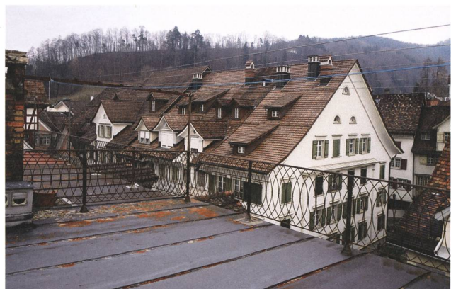
Die «Zinnen», die Dachterrassen des 19. Jahrhunderts, dienten vor allem dem Trocknen der Wäsche. Heute sind sie ein begehrter Aussenraum für Altstadtwohnungen, wie hier in Lichtensteig. Foto: Kantonale Denkmalpflege St. Gallen.
