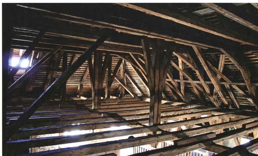
Das Schloss Werdenberg erhielt nach dem Brand von 1695 einen neuen Dachstuhl. Der Blick in die zweite Ebene des Daches zeigt die Hängesäulen, an denen die untere Kehlbalkenlage aufgehängt ist. Dadurch ergibt sich im ersten Dachgeschoss ein weitgehend stützenfreier Lagerraum. Foto: Kantonale Denkmalpflege St. Gallen.
