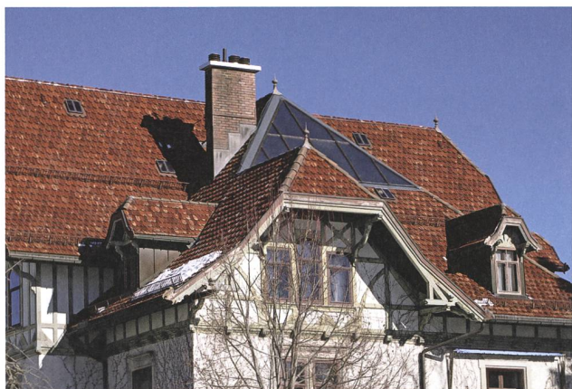
Hanni Diethelm entwarf für die Villa Grauer in Degersheim thermische Kollektoren, die so schön sind wie eine Atelierverglasung. Foto: Kantonale Denkmalpflege St. Gallen.
