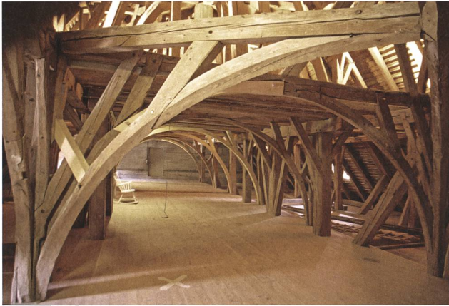
Der Dachstuhl, der die drei alten Flügel der Konventsbauten des Klosters Marienberg in Rorschach überspannt, wurde kurz nach 1500 in berauscher Eleganz errichtet. Die Auswechslung einzelner schadhafter Hölzer ist an deren heller Farbe ersichtlich. Foto: Kantonale Denkmalpflege St. Gallen.
