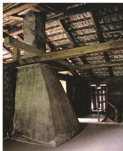
Einfaches Rafendach in einem (abgebrochenen) Bauernhaus von 1591 in Vilters. Aus dem Obergeschoss sieht man direkt ins Dach, im Vordergrund der Rauchfang einer Herdstelle. Foto: Kantonale Denkmalpflege St. Gallen.
