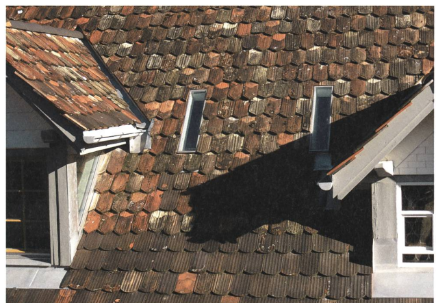
Wenn keine Belüftung, sondern nur Licht gefragt ist, wirken diese von Paul Rutz entwickelten Schlitzfenster wahre Wunder. Der ziegelbündige Einbau ohne Einfassung bewirkt, dass sie weitgehend in der Dachhaut verschwinden (Löwengasse Lichtensteig). Foto: Kantonale Denkmalpflege St. Gallen.
