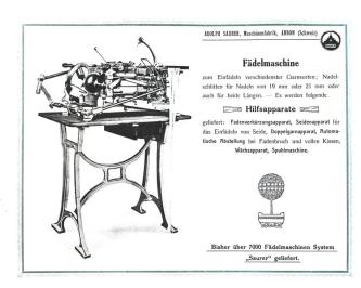
Abb. (6): Die Fädelmaschine der Maschinenfabrik Adolph Saurer bedeutete eine wesentliche Arbeitserleichterung. Quelle: TexBib T 7.1.
