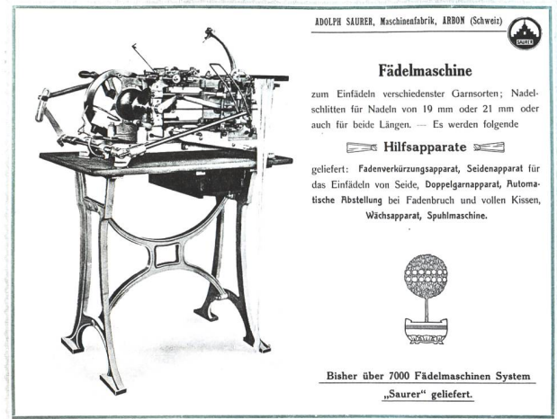
Abb. (6): Die Fädelmaschine der Maschinenfabrik Adolph Saurer bedeutete eine wesentliche Arbeitserleichterung. Quelle: TexBib T 7.1 .
