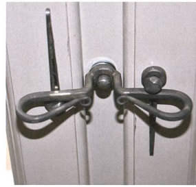
Originalgetreuer Nachbau von Fenstern für ein Kloster (Fotos: fensterinform gmbh)
