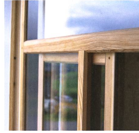
Originalgetreuer Nachbau von Fenstern für ein Appenzeller Haus (Fotos: fensterinform gmbh)
