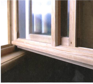
Originalgetreuer Nachbau von Fenstern für ein Appenzeller Haus (Fotos: fensterinform gmbh)
