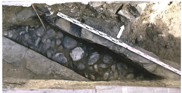
St. Gallen, Marktplatz/Einfahrt Metzgergasse. Offener Wasserkanal des 16. Jahrhunderts aus bearbeitetem Sandstein. Foto KASG.
