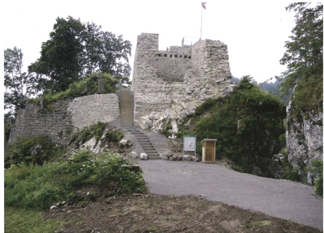
Wildhaus-Alt St. Johann, Wildenburg. Ansicht des Hauptturms nach der Restaurierung. Foto H. Hauser.
