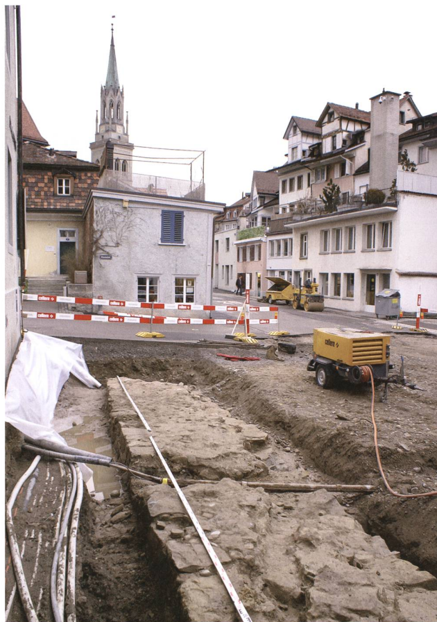
St. Gallen, Zeughausgasse. Die Schiedmauer von 1567 trennt Kloster (links) und Stadt (rechts). Vorne freigelegte Mauerkrone. Hinten ist die Schiedmauer in die Häuserzeile integriert. Foto KASG.
