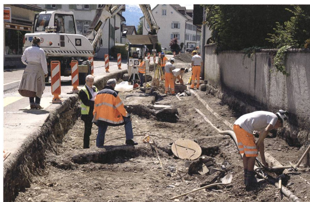
Rapperswil-Jona, Kempraten, Kreuzstrasse. Schnappschuss während der Arbeiten. Da der Verkehr auf der Strasse weiterhin rollen musste, waren Rücksichtnahme und Vorsicht geboten. Foto KASG.
