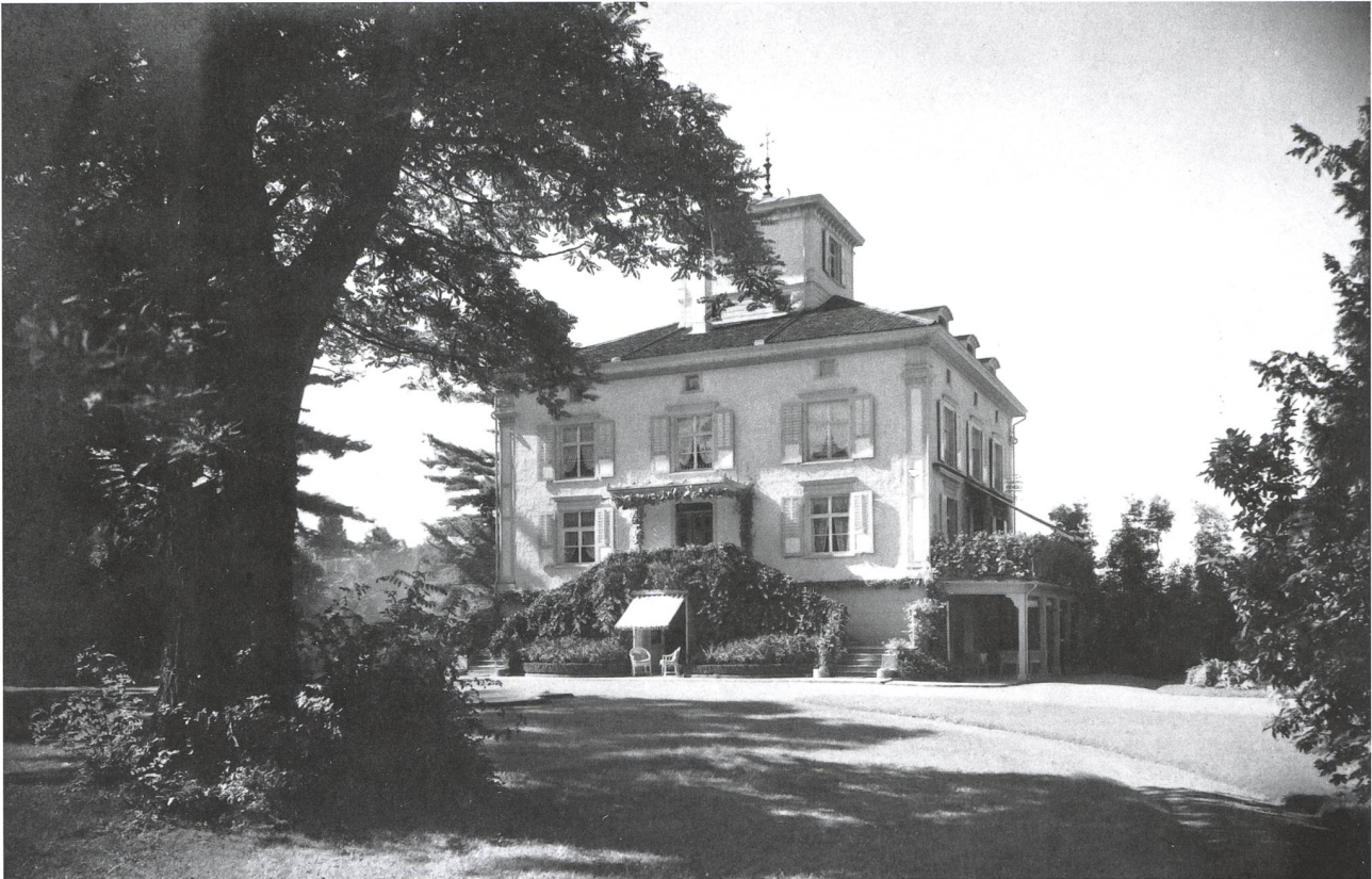
Goldach, Landsitz Mariahalden. Wohngebäude. Foto wohl 1930er-Jahre, (ehemals) Familienarchiv Philipp Lafont-Kriesemer, St. Gallen. Abzug im Archiv Johannes Huber, St. Gallen (nach dieser Vorlage publiziert).
