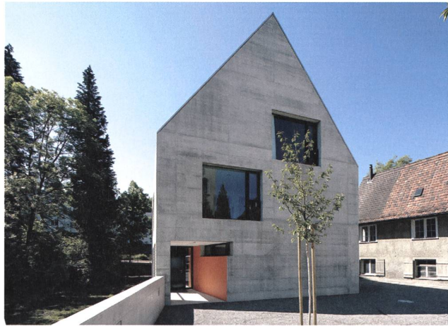
St.Gallen, Pfarreiheim St.Georgen von Gähler Architekten/Binotto + Gähler. Foto Gähler Architekten, St.Gallen.
