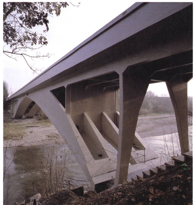
Uzwil, Henau, Thurbrücke von Robert Maillart 1933. Aus: Billington, David P.: Robert Maillart und die Kunst des Stahlbetonbaus, Zürich/München 1990, S. 19.
