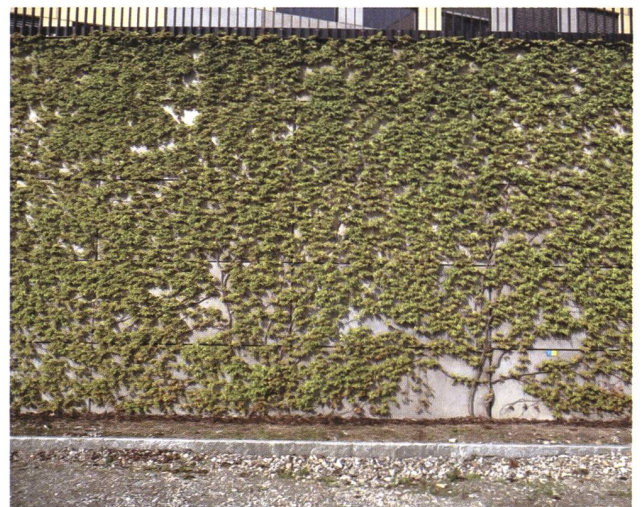
Begrünte Betonmauer bei der St.Leonhardsbrücke in St.Gallen. Foto Kant. Denkmalpflege.
