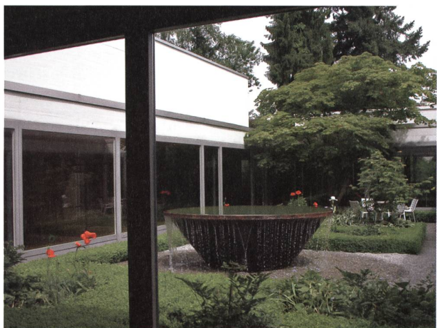
Rapperswil, evang. Kirchgemeindehaus, erbaut 1963 von Oscar Bitterli und dank einem neuen Inventar seit kurzem unter Schutz gestellt. Foto Kant. Denkmalpflege.
