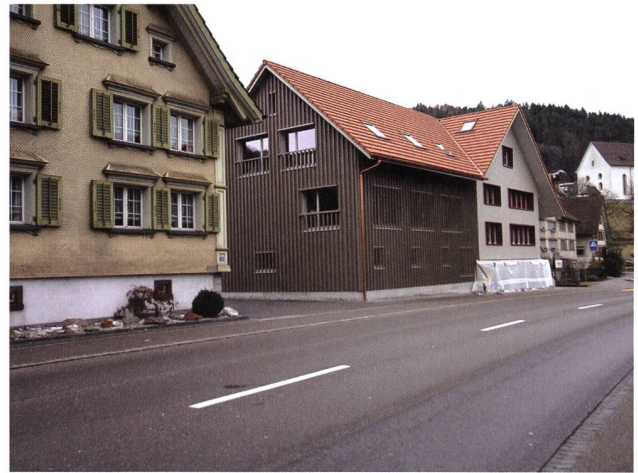
Der nicht geschützte Kreuzfirsthof in der Balgacher Ortsbildschutzone erhielt 2011 einen (wiederum hölzernen) Ersatzbau für die Stallscheune. Dank des Holzrasters vor den Fenstern erscheint die Strassenfassade des Neubaus schon aus kurzer Distanz als eine geschlossene Fläche. (Foto: Kant. Denkmalpflege)
