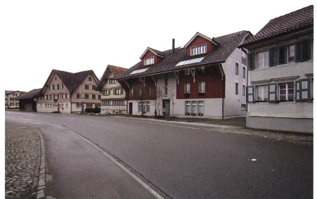
1992 erhielt die Eigentümerschaft die Bewilligung für den Ausbau der Stallscheune im Dorf Oberbüren zu Wohnzwecken. Nachdem ohne Erlaubnis die ganze Scheune abgerissen worden war, entschied man sich für einen volumengleichen Neubau. Während das grosse Vordach noch an die ehemalige Scheune erinnert, führen die Materialisierung mit Kalksandsteinen und die grossen Dachaufbauten zu einem zwiespältigen Gesamteindruck. (Foto: Kant. Denkmalpflege)
