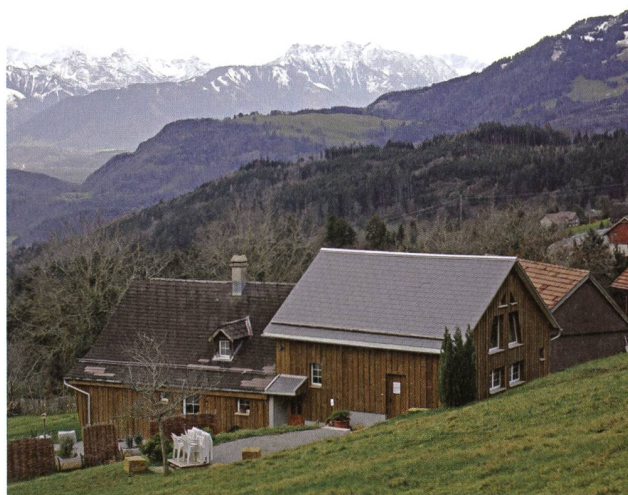
Altstätten, Gätziweg. Oben: Scheunenausbau an einem nicht geschützten ehemaligen Bauernhaus. Der Holzraster bricht die grosse Fensterfläche. – Unten: Einbau eines Praxiszimmers in die dem kleinen Wohnhaus angehängte Scheune, an der Giebelfront gegen den Hang stören auch grössere und aufgrund der Holzkonstruktion schräge Fensterformen nicht. (Foto: Kant. Denkmalpflege)
