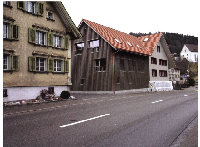
Der nicht geschützte Kreuzfirsthof in der Balgacher Ortsbildschutzzone erhielt 2011 einen (wiederum hölzernen) Ersatzbau für die Stallscheune. Dank des Holzrasters vor den Fenstern erscheint die Strassenfassade des Neubaus schon aus kurzer Distanz als eine geschlossene Fläche. (Foto: Kant. Denkmalpflege)
