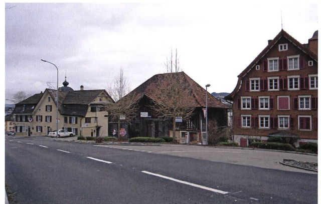
Die klassizistische Remise des Gasthofs Bierhaus in Oberuzwil aus dem Anfang des 19. Jahrhunderts ist nicht nur ein historischer Zeuge, sondern auch wegen des räumlichen «Rahmens» ein wichtiger Bestandteil der zugehörigen repräsentativen Bauten. (Foto: Kant. Denkmalpflege)
