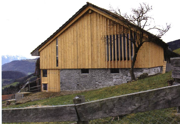
Tübach, Scheune des Restaurants Landhaus. Die Türflügel dienen in der Dämmung auch als Sichtschutz von aussen. (Foto: Tübag, Tübach)
