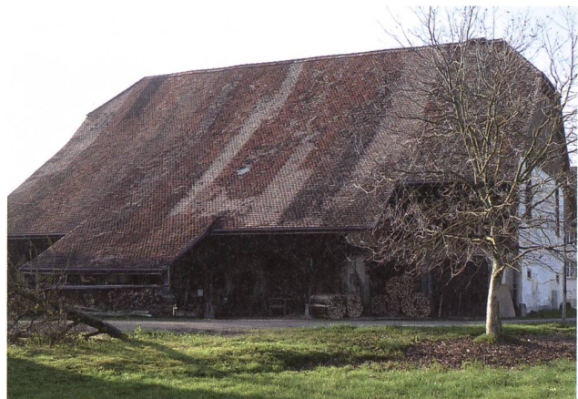
Rapperswil-Jona, Kloster Wurmsbach. Das Dach des Pferdestalls wurde 2004 unter Verwendung der alten Ziegel neu eingedeckt. (Foto: Kant. Denkmalpflege)
