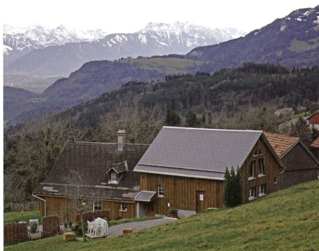
Altstätten, Gätziweg. Oben: Scheunenausbau an einem nicht geschützten ehemaligen Bauernhaus. Der Holzraster bricht die grosse Fensterfläche. – Unten: Einbau eines Praxiszimmers in die dem kleinen Wohnhaus angehängten Scheune, an der Giebelfront gegen den Hang stören auch grössere und aufgrund der Holzkonstruktion schräge Fensterformen nicht. (Foto: Kant. Denkmalpflege)
